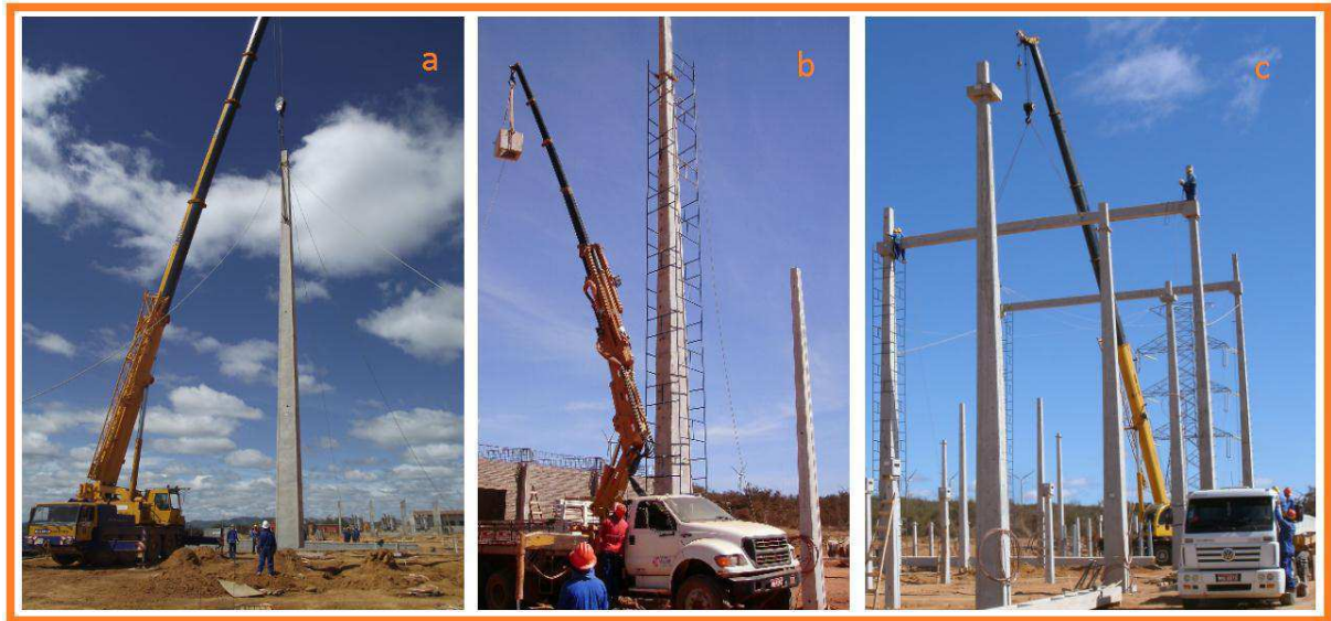
Figura 13 – Montagem de Pórticos: (a) implantação de postes (b) fixação de anéis (c) assentamento de vigas
