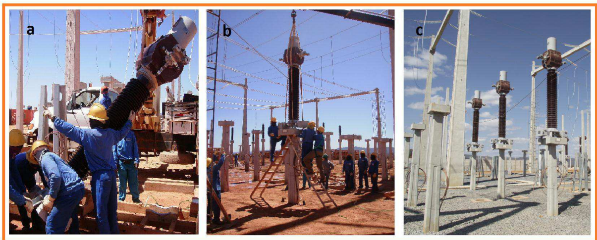
Figura 23 – Montagem do TC: (a) içamento (b) fixação (c) montagem acabada
