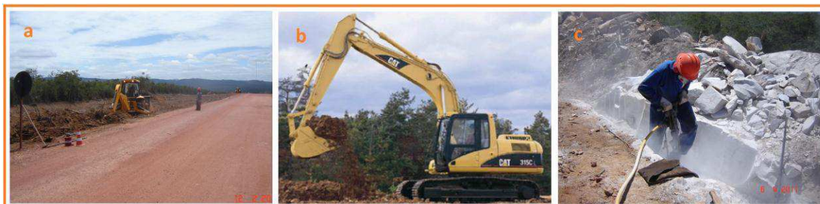
Figura 33 – Abertura de Valas: (a) escavadeira sobre rodas (b) escavadeira sobre esteiras (c) martelo pneumático
