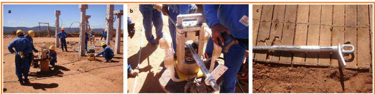
Figura 15 – Prensagem de Cabos: (a) prensa hidráulica (b) processo de prensagem (c) terminal prensado
