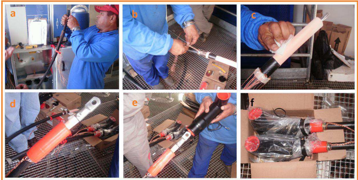
Figura 36 – Execução de Mufla Termocontrátil: (a) corte do cabo (b) aterramento da blindagem (c) limpeza da parte isolante (d) estresse cone e terminal de compressão (e) encaixe do corpo isolante (f) mufla acabada
