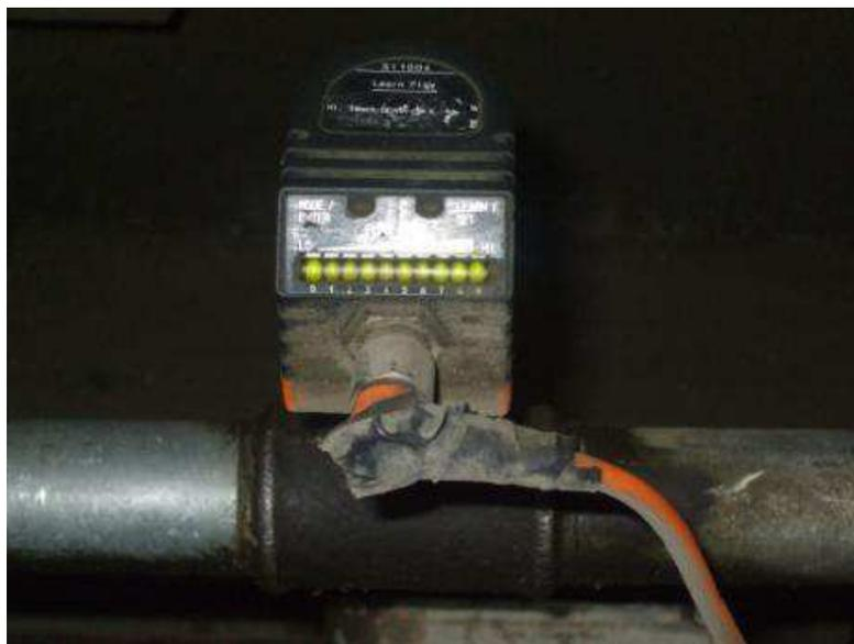
Figura 3.3 - Transdutor de vazão de óleo.
