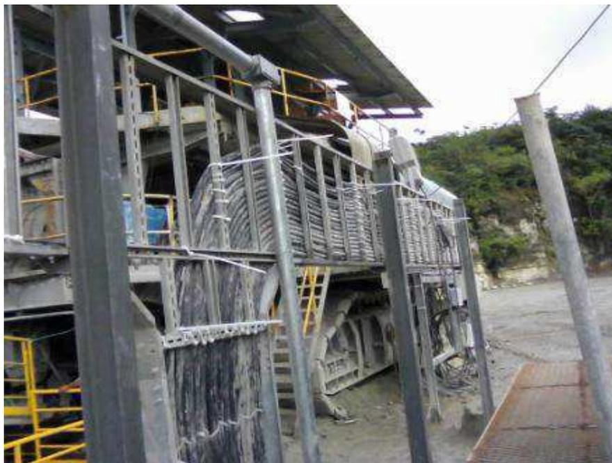
Figura 3.19 - Leitos de Cabos.
