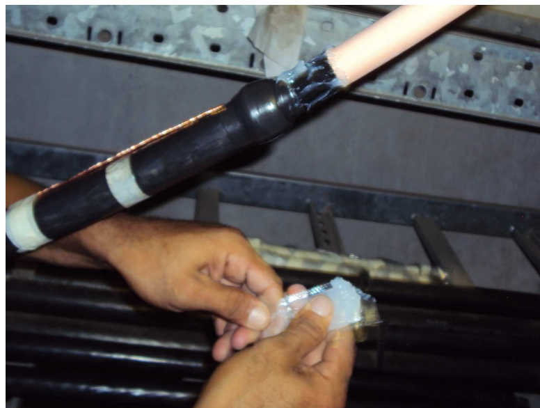
Figura 14: Resultado final da aplicação da graxa semicondutora.
