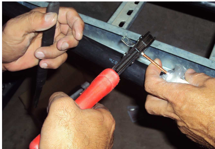
Figura 26: Crimpagem do terminal conector.
