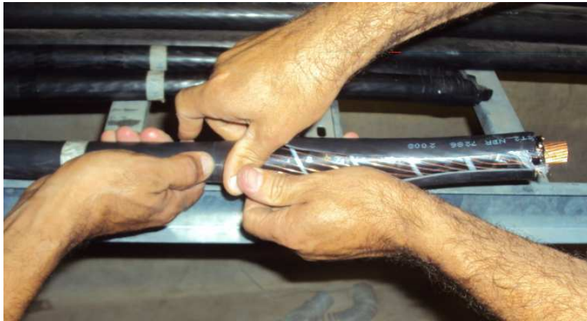
Figura 2: Retirada da isolação externa do cabo.
