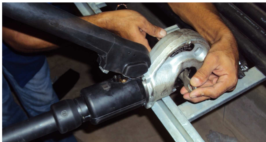
Figura 6: Fixação do conector terminal com alicate hidráulico.
