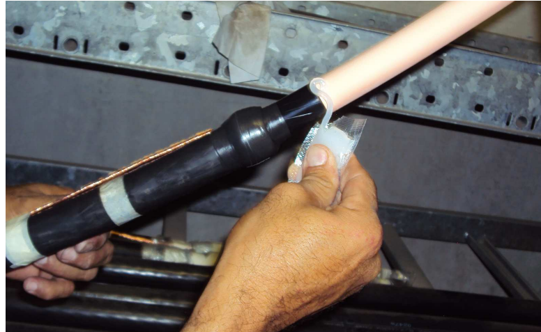
Figura 13: Aplicação da graxa de silicone.
