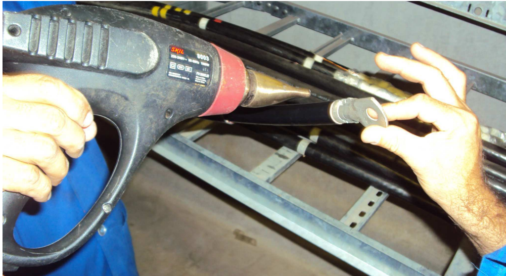
Figura 7: Utilizando aquecedor para soltar camada semicondutora.
