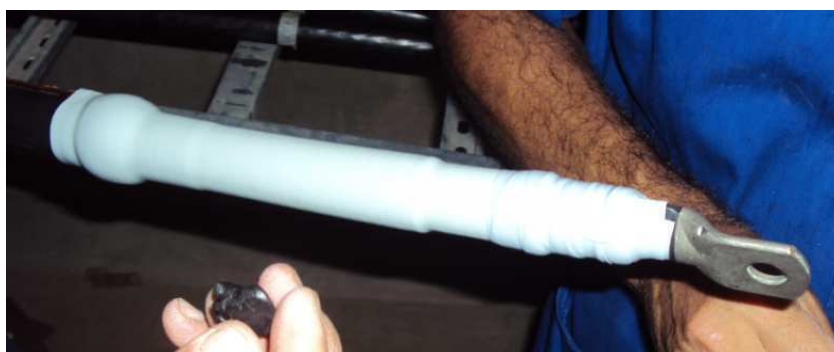
Figura 24: Resultado final da aplicação da tira de silicone Schotch MR 70.
