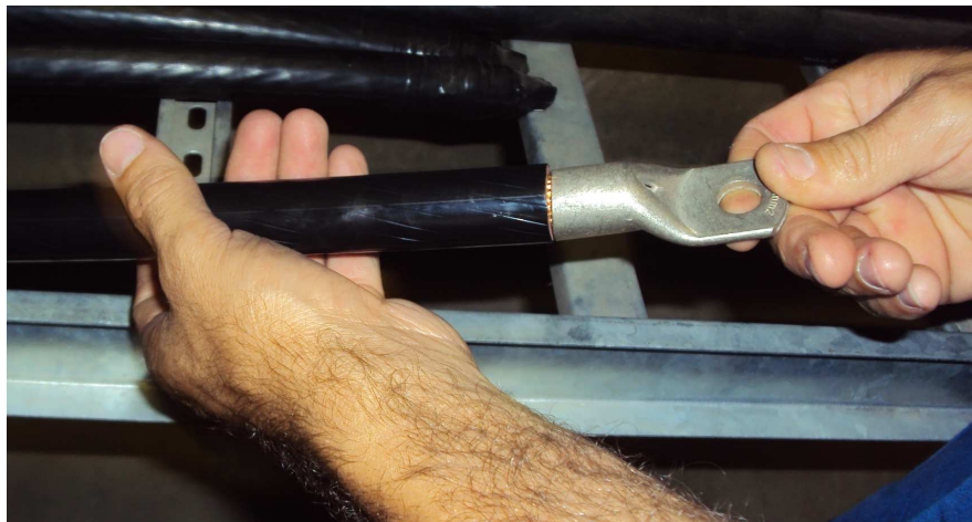
Figura 5: Colocação do conector terminal.
