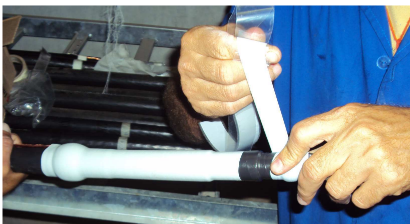
Figura 23: Aplicação da tira de silicone Schotch MR 70.
