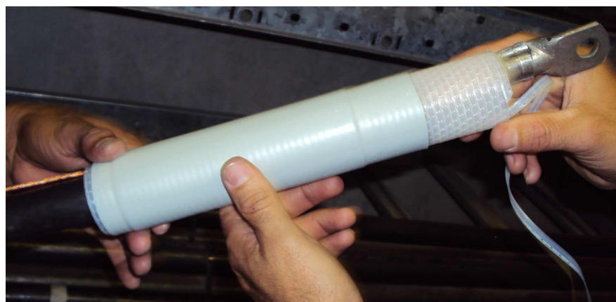
Figura 16: Colocação do isolador de silicone.
