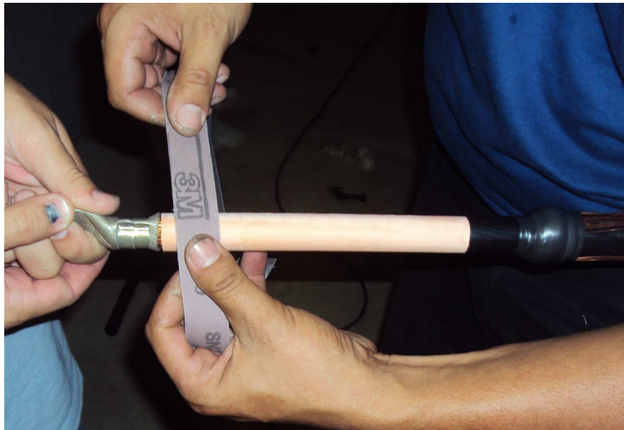
Figura 11: Lixando a isolação do cabo.
