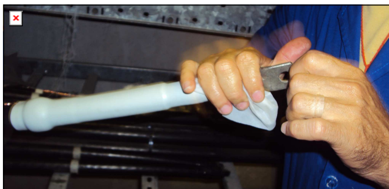
Figura 20: Higienização da ponta do cabo.
