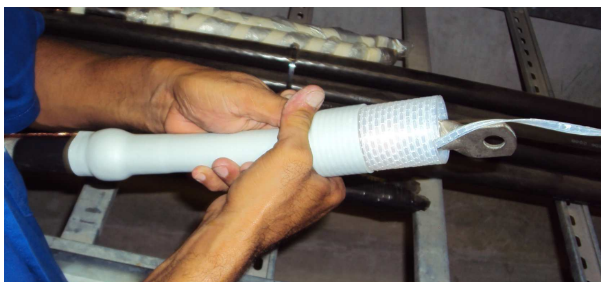
Figura 17: Remoção da fita plástica.
