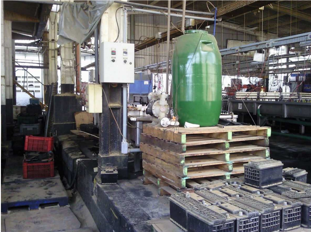
Figura 46. Sistema de Refrigeração depois de montado.
