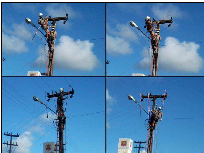
Figura 9 - Aterramento da parte montante do poste. Junho de 2012.
