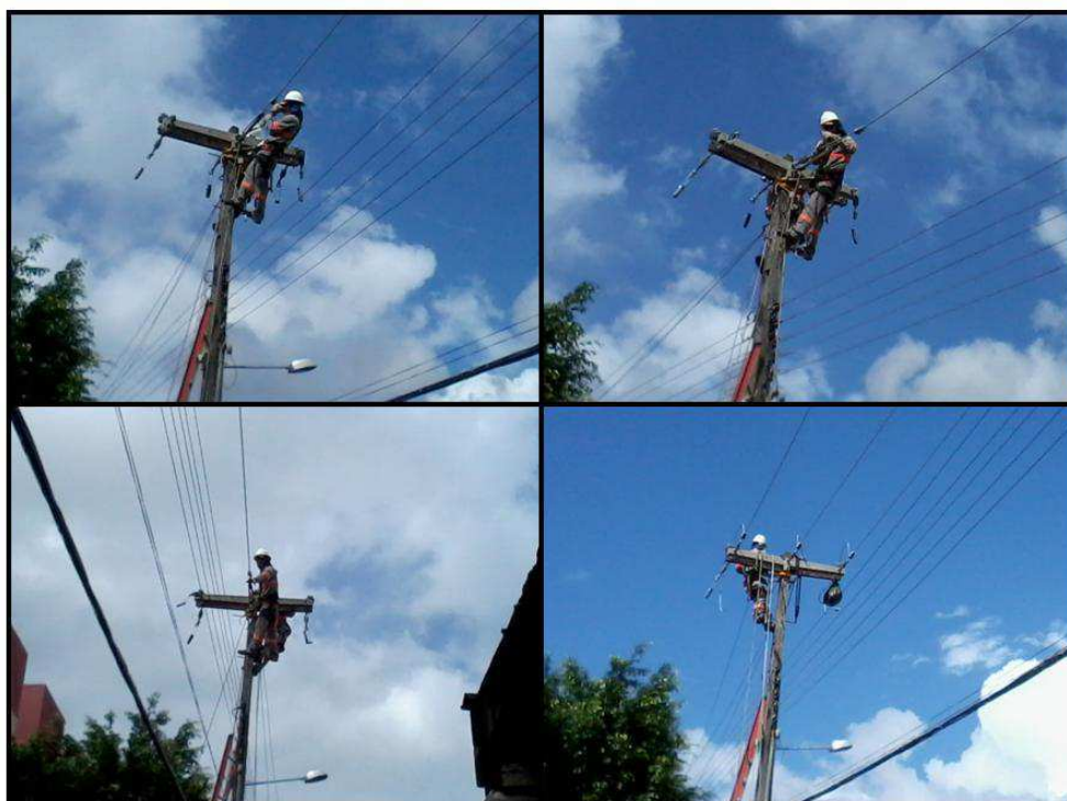
Figura 6 - Instalação de cabo de MT. Junho de 2012.
