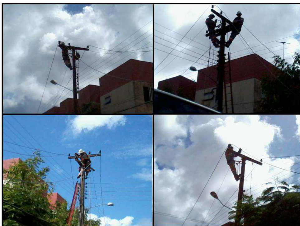
Figura 4 - Retirada dos cabos. Junho de 2012.
