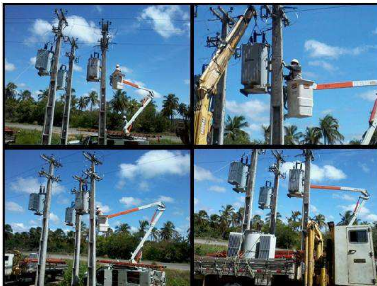
Figura 21 - Manutenção dos reguladores. Maio de 2012.
