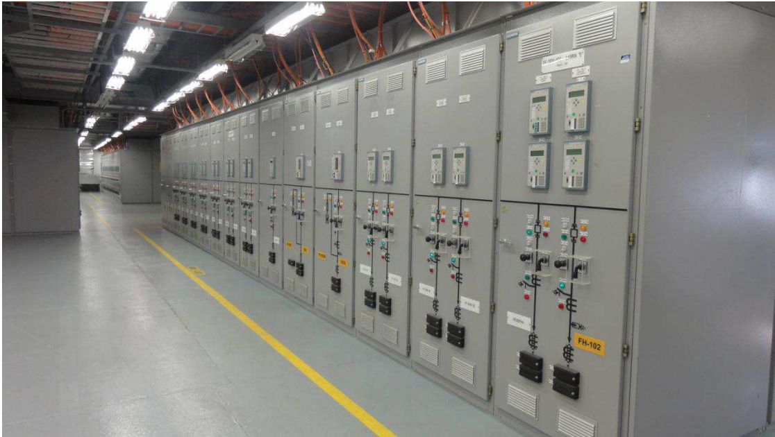
Figura 6. Vista da Sala 102.
