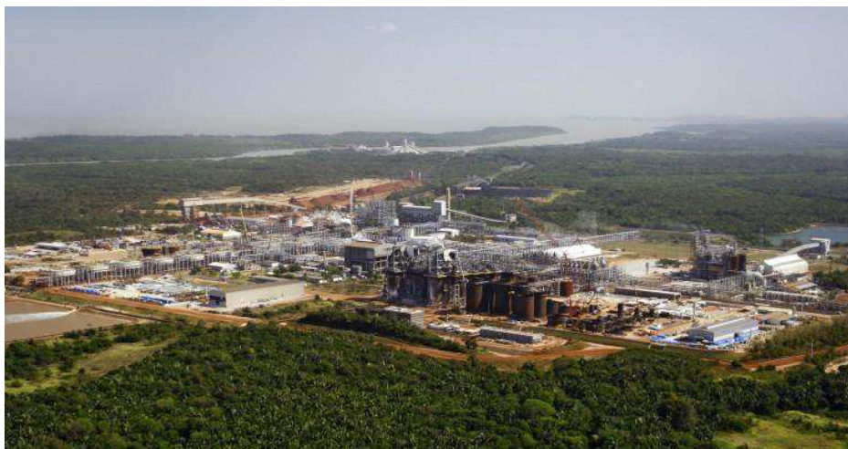
Figura 2. Vista aérea da Refinaria da ALUMAR [1].
