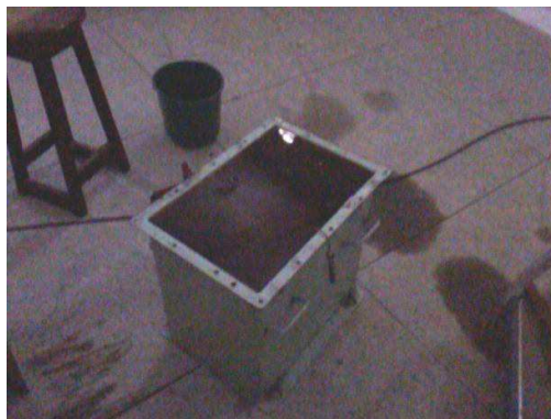
Figura 45. Transformador aberto durante a introdução do óleo.
