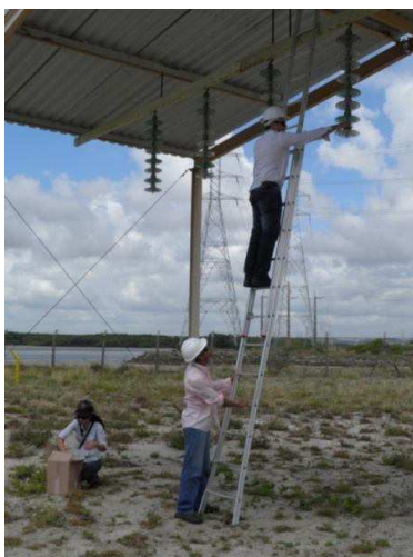
Figura 5. Registro da retirada de unidades de isoladores de vidro.
