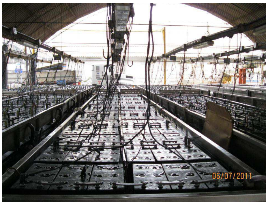
Figura 09: Etapa de formação das baterias
