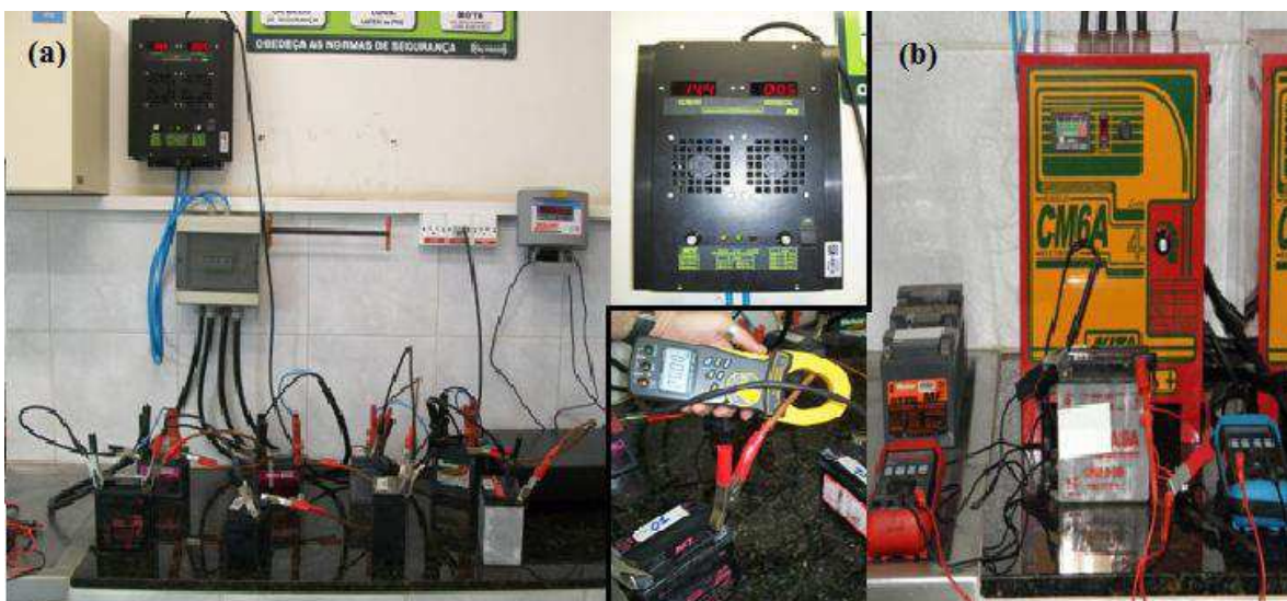
Figura 20: Estrutura de ensaios de carga de baterias. (a) Utilizando o Carregador Inteligente. (b) Utilizando o Carregador CM6A.
