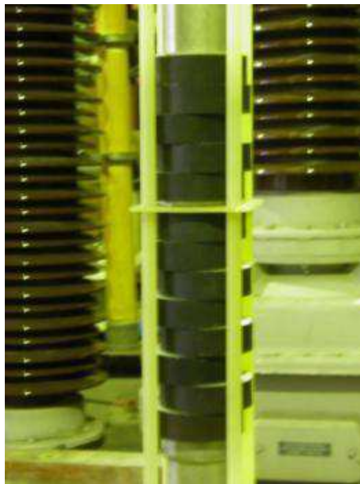
Figura 7 - Parte da coluna de varistores desalinhadas.
