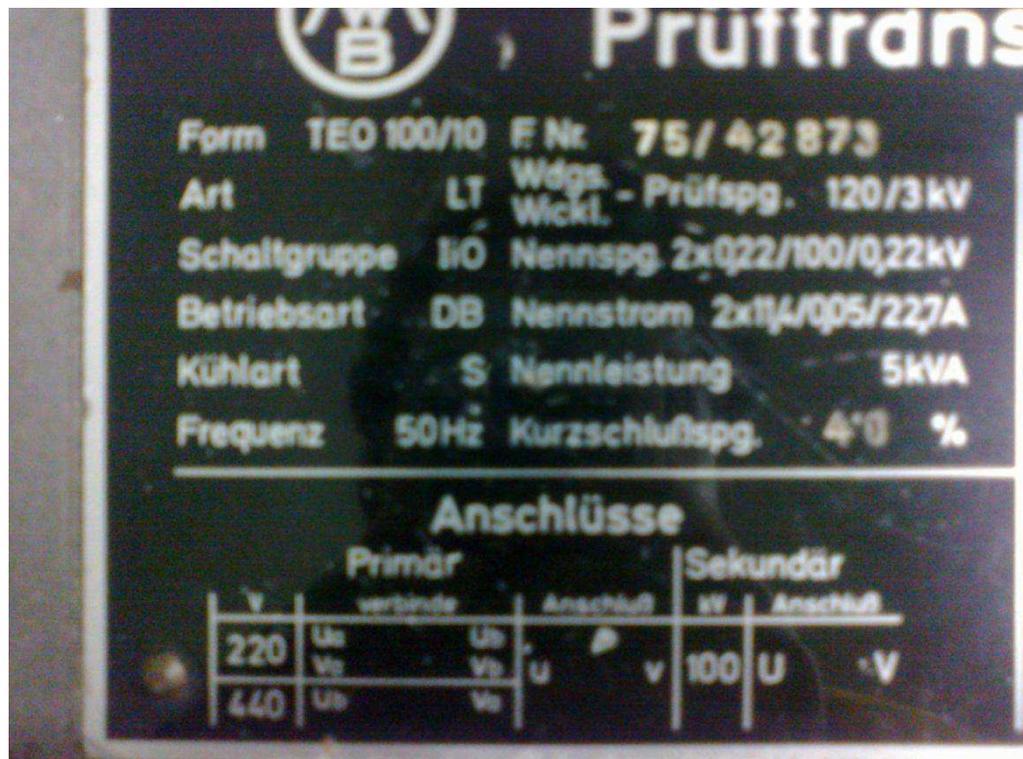
Figura 19. Fotografia dos dados de placa de um transformador do LAT.
