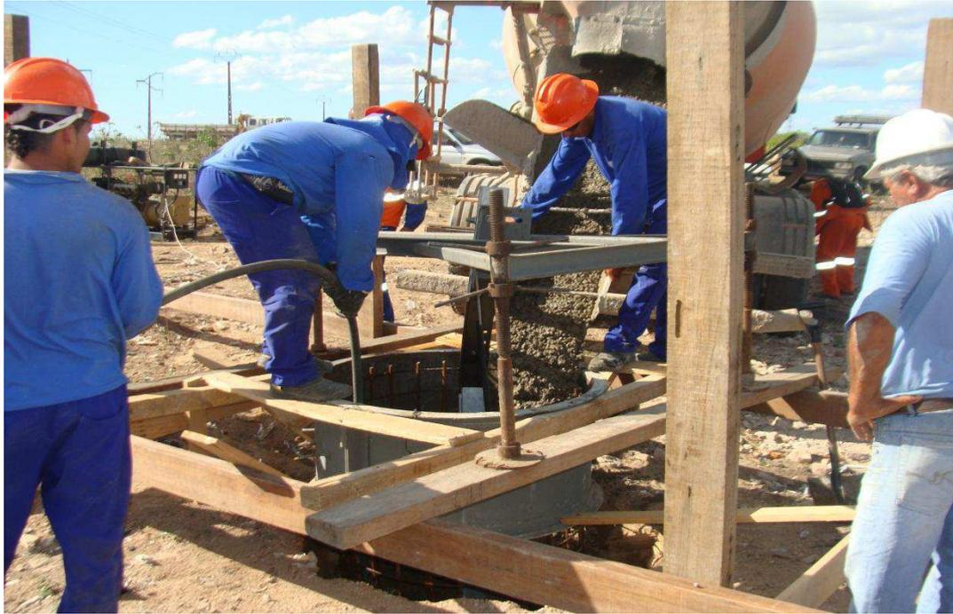
Figura 3.14 – Fotografia da aplicação de Concreto usinado.
