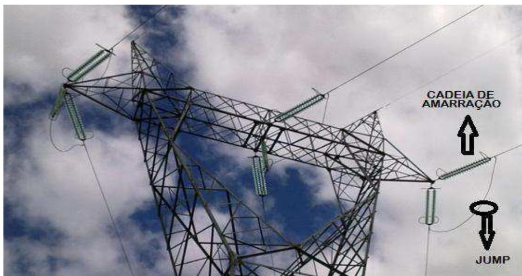
**Figura 2.6 – Fotografia de estrutura com a cadeia de ancoragem.**
