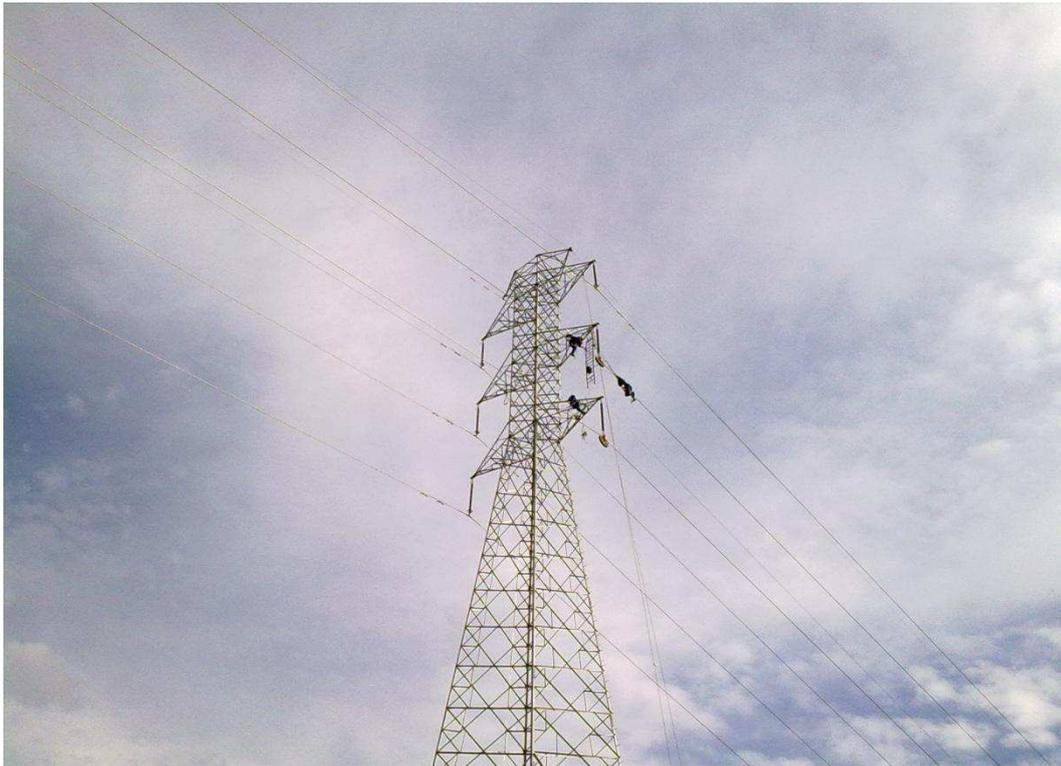
**Figura 3.23 – Fotografia de montadores realizando manobras de Grampeação.**
