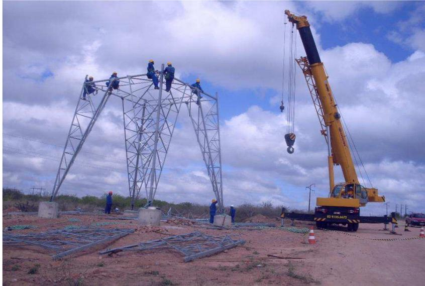
**Figura 3.18 – Fotografia da montagem de estrutura utilizando guindaste.**
