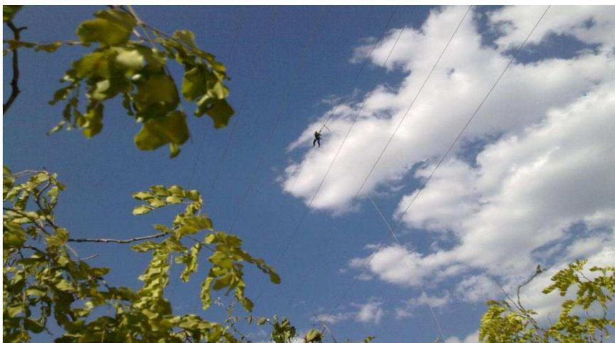
**Figura 3.22. Fotografia de um montador prendendo o cabo auxiliar (“Ormezo”).**
