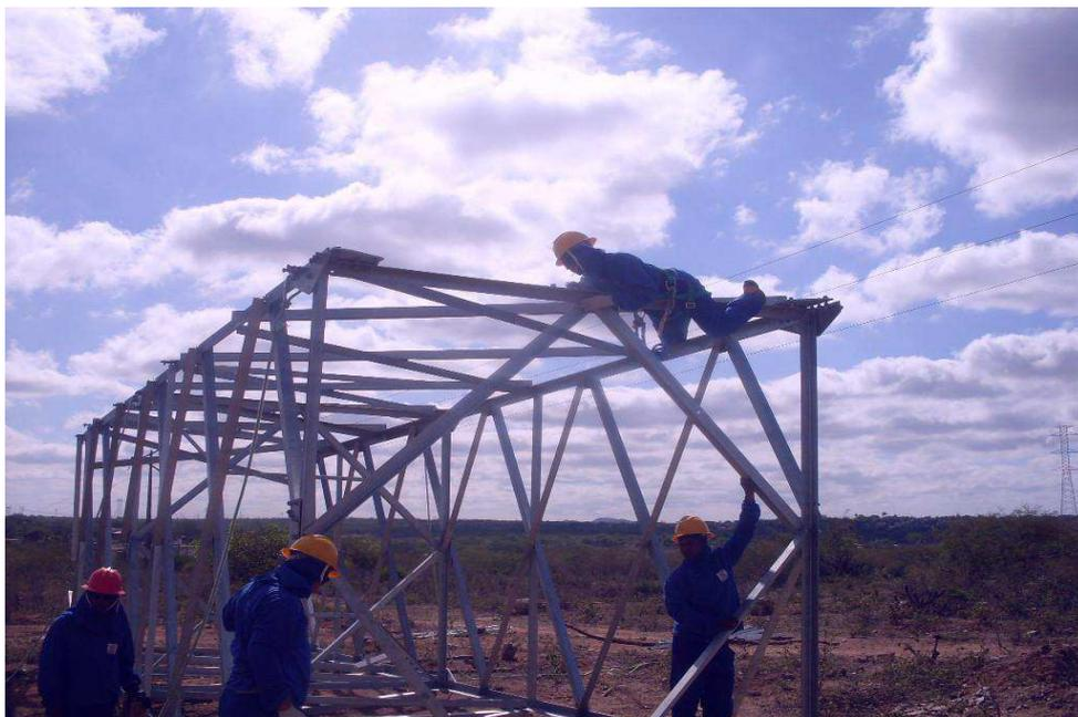
Figura 3.16 – Fotografia da pré-montagem para utilização de guindaste.
