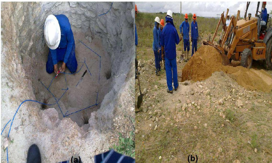
**Figura 3.11 - (a) Fotografia da malha de detonação. (b) Fotografia do abafamento da explosão.**
