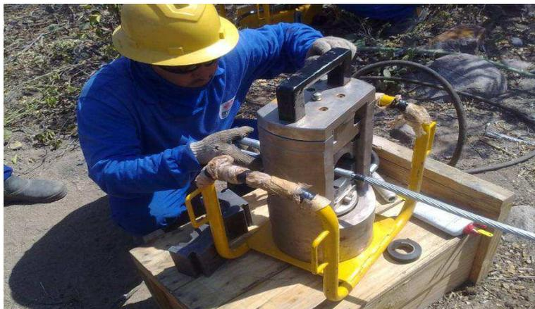
**Figura 3.21 – Fotografia da prensagem da extremidade do cabo na luva de ancoragem.**
