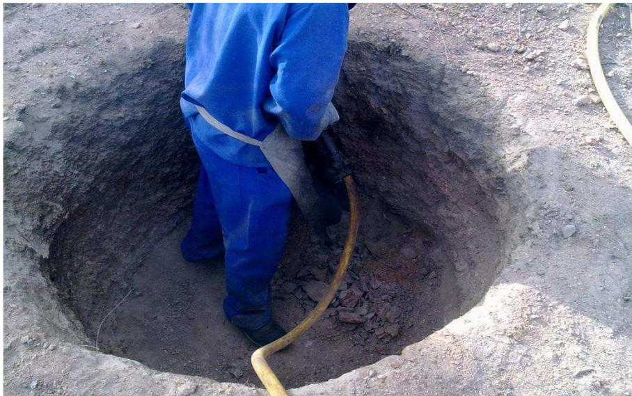
**Figura 3.10 - Fotografia da utilização do rompedor na escavação.**
