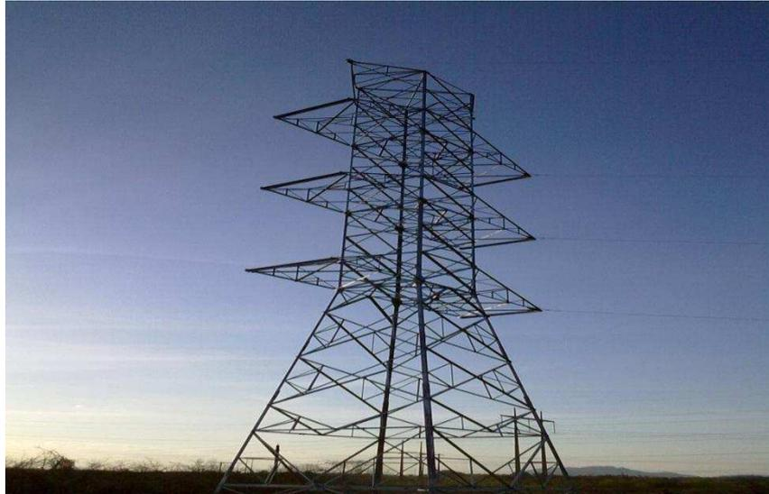
**Figura 2.4 - Exemplo de estrutura com circuito duplo**
