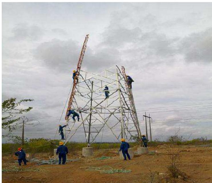
**Figura 3.17 – Fotografia da montagem de estruturas utilizando os "facões".**
