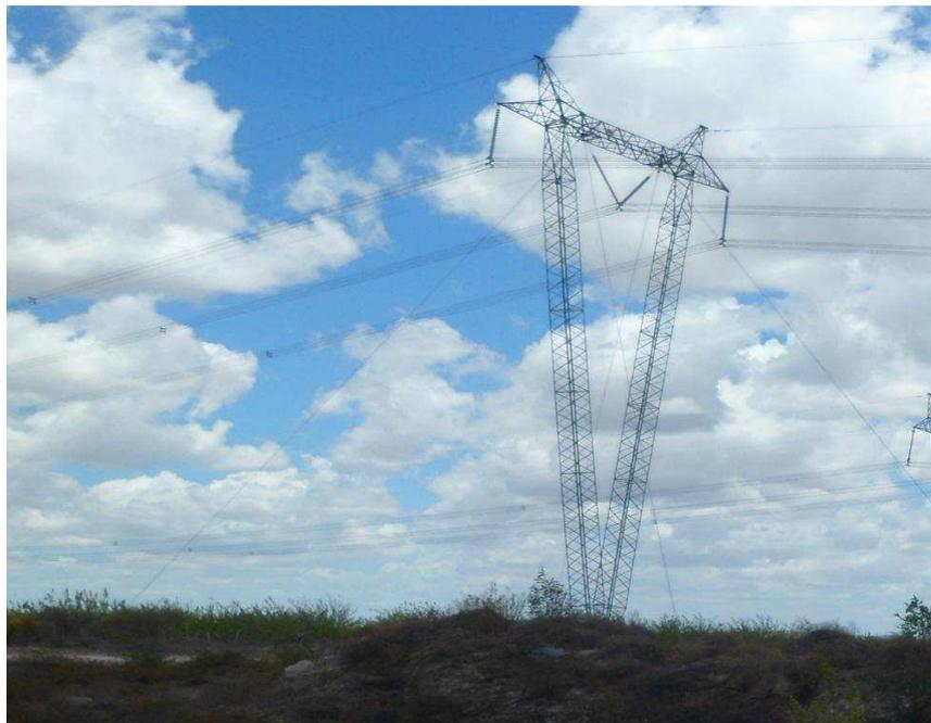
Figura 2.7 - Fotografia de uma estrutura estaiada, linha de 500 kV.
