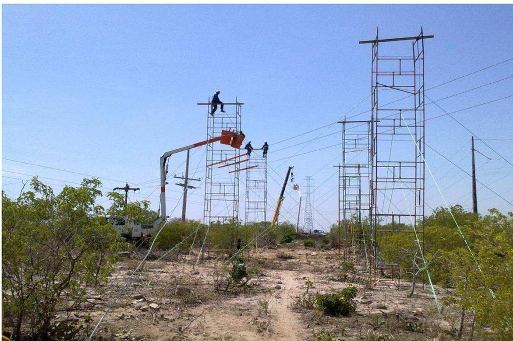
**Figura 3.25 - Fotografia mostrando duas travessias, ao fundo uma travessia de 138 kV, a frente uma travessia de 13,8 kV.**
