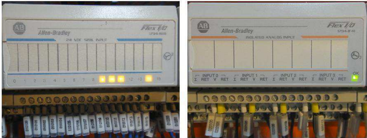
FIGURA 3.10 – MÓDULOS DE ENTRADA DIGITAL A (ESQUERDA) E ENTRADA ANALÓGICA A (DIREITA)
