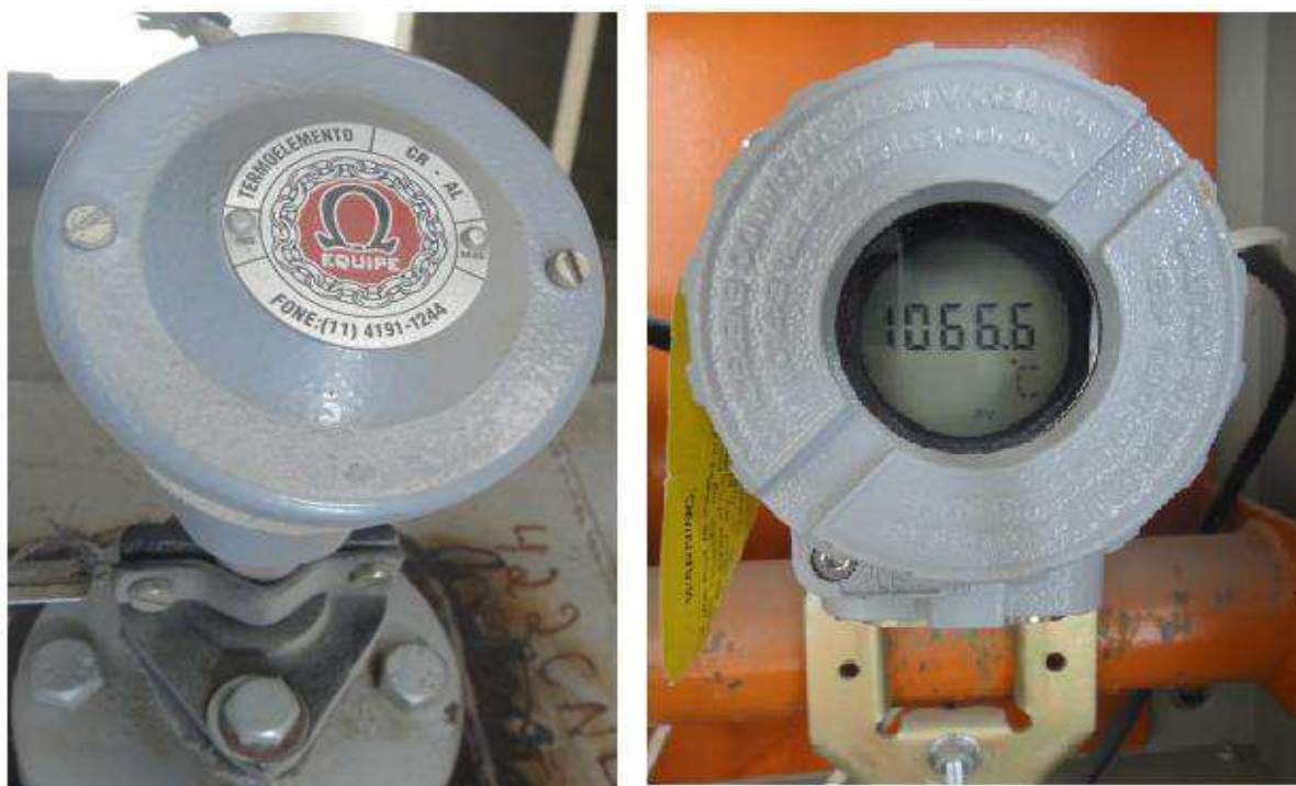
FIGURA 3.16 – TERMOPAR(FIGURA A ESQUERDA) E TRANSDUTOR(FIGURA A DIREITA)
