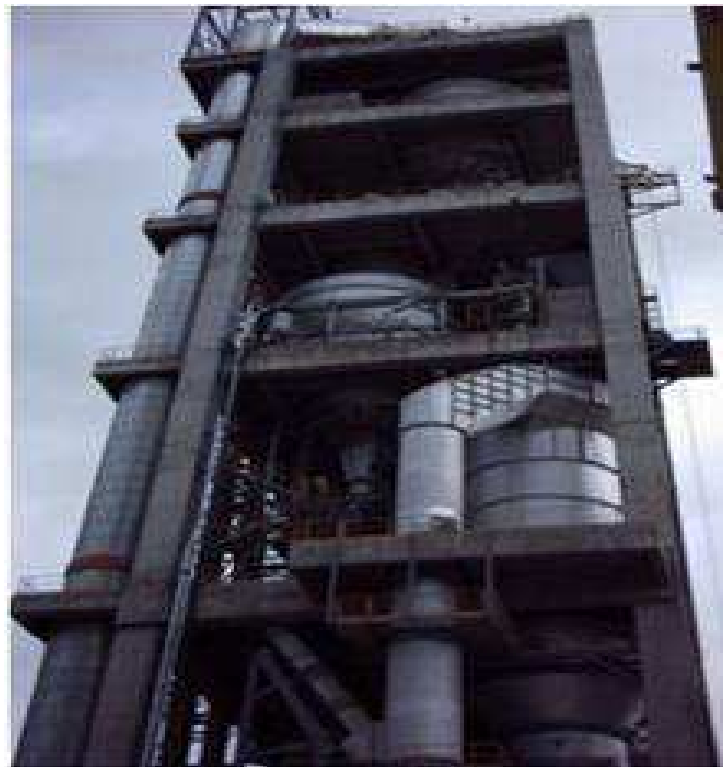
FONTE: CCB CIMPOR, 2006 FIGURA 2.7 – PRÉ-AQUECEDOR
