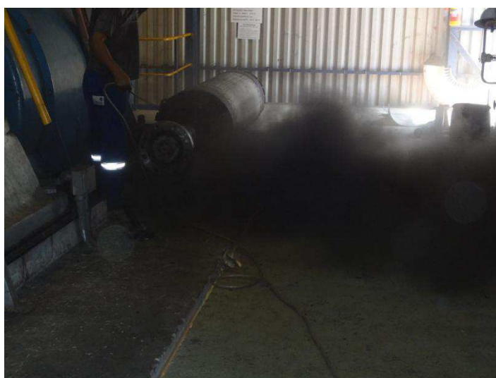
Figura 5.2 - Técnicos limpando o rotor do gerador principal.
