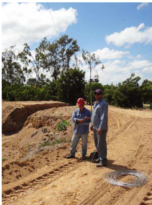
Figura 5.3 - Manutenção da rede de distribuição.
