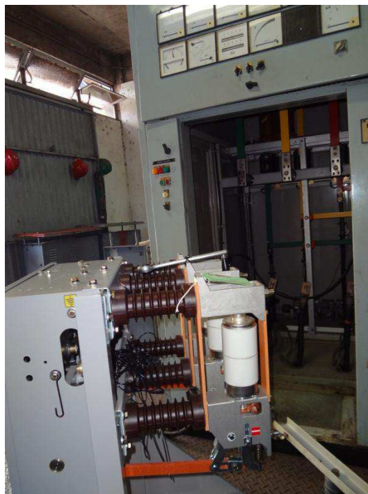
Figura 4.11 - Disjuntor novo sendo instalado.
