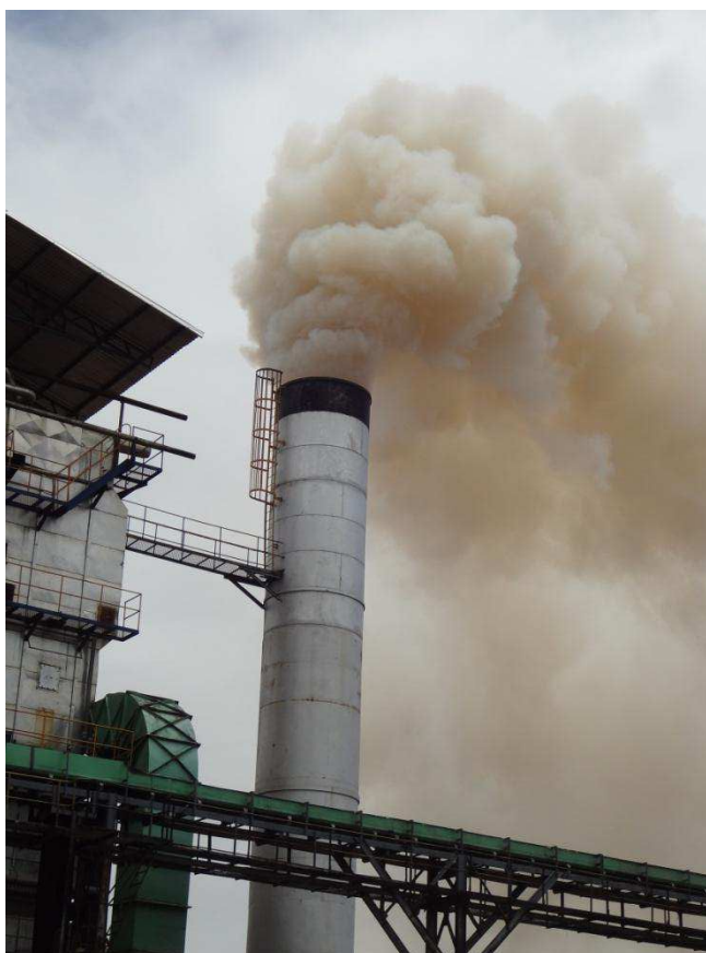
Figura 6.1 - Descarga de vapor pela chaminé.
