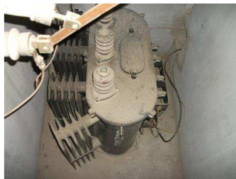
Figura 3.17 –a) Subestação abrigada b) Transformador da subestação
