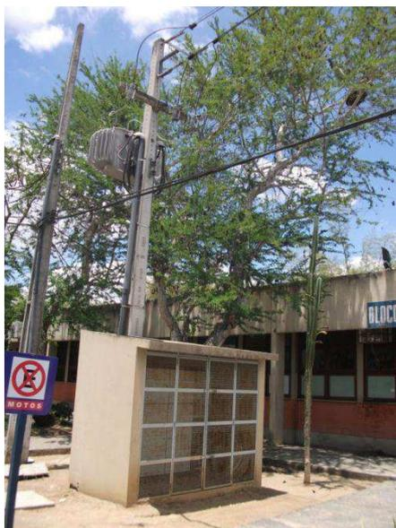
Figura 3.9 – Cabine do barramento do transformador
