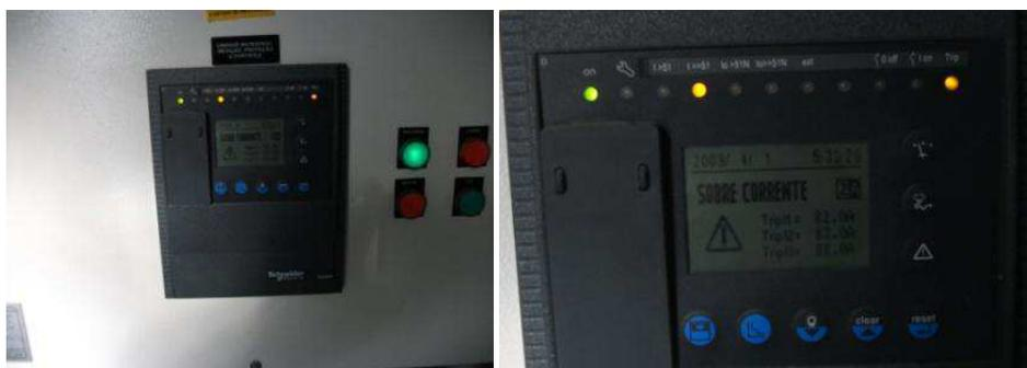
Figura 3.8 – a) Relé digital b) Função sobrecorrente detectada
