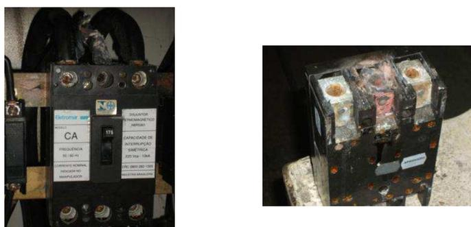
Figura 3.15 –a) Disjuntor com condutor superaquecido b) Comprometimento da conexão
