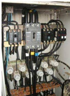
Figura 3.16 –a) Retirada do disjuntor b) Novo Disjuntor instalado
