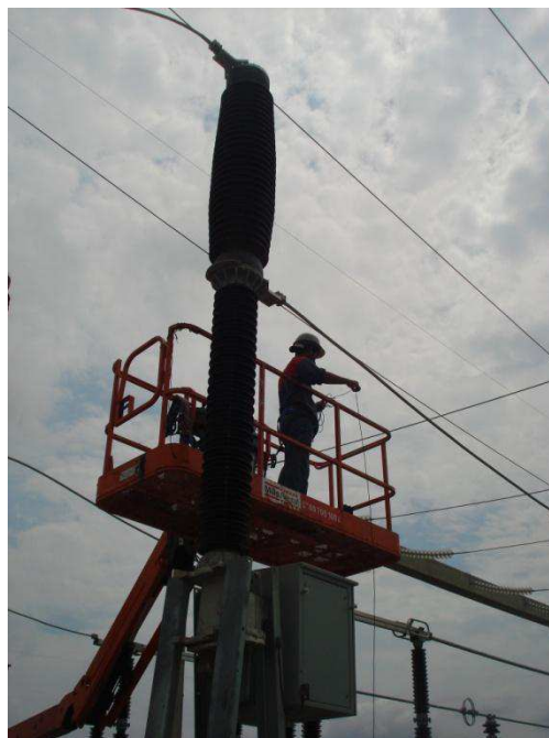
Figura 2.6 – Disjuntor a SF 6
