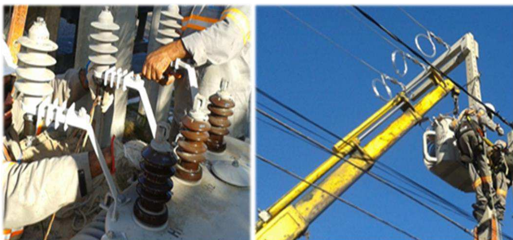
Figura 7. Instalação de para-raios. Figura 8. Instalação do transformador.
