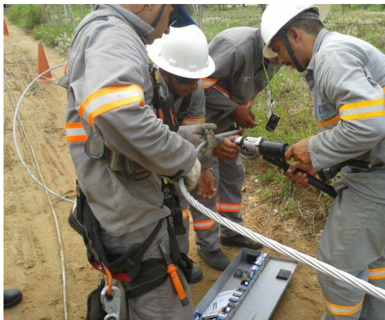
Figura 124. Emenda no cabo 4/0 AWG.
