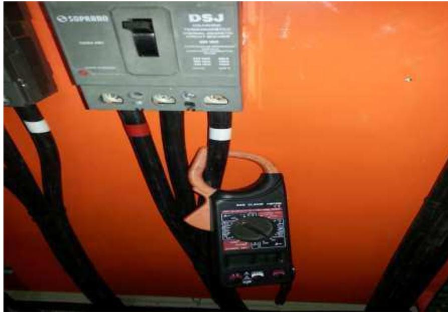
Figura 5.5- Corrente do quadro de resfriado- 04/12/2013
