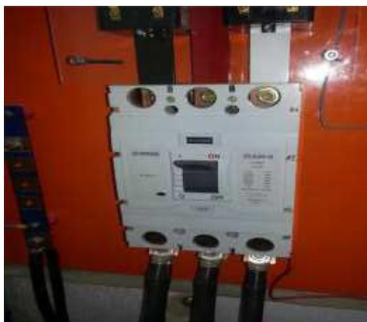
Figura 5.8 – Disjuntor do quadro de força geral- 04/12/2013
