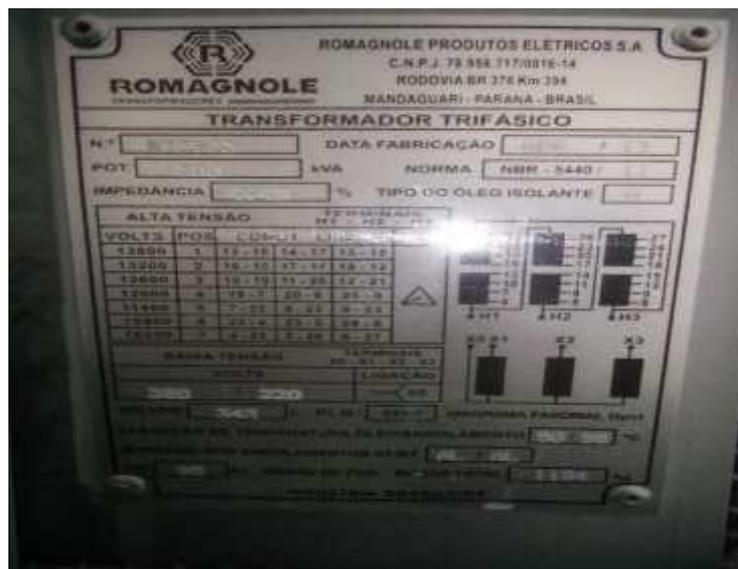
Figura 5.10 – Plaqueta do Transformador 300 kVA- 05/12/2013
