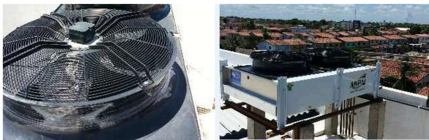
Figura 3.8 - Ventilador dos Condensadores
