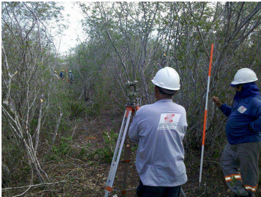
Figura 5. Conferencia de Vão Avante / Desníveis / Deflexão.
