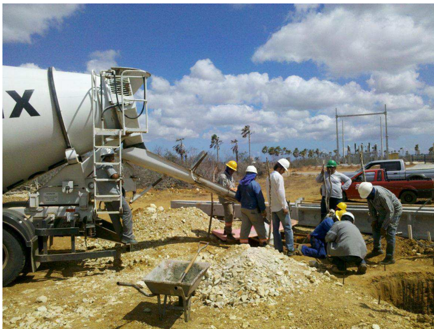
Figura 18. Concretagem do 1º Estágio – Concreto Magro.
