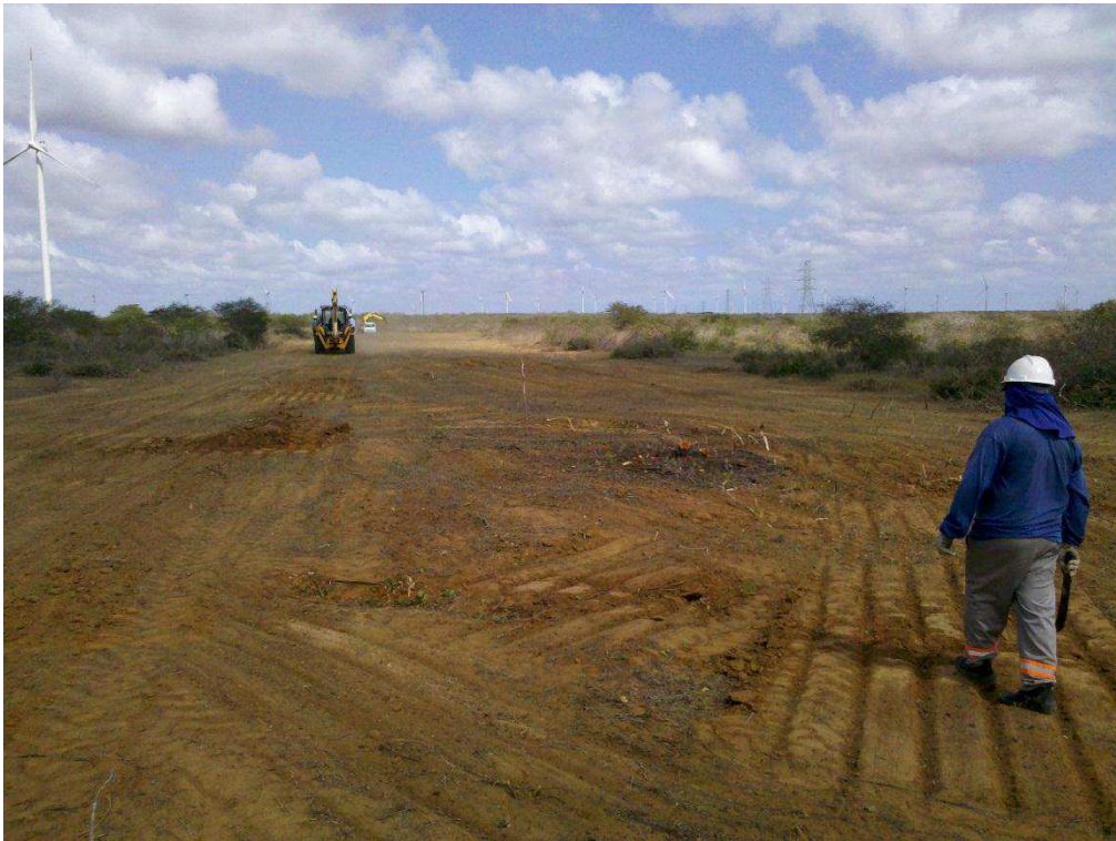
Figura 7. Limpeza de Faixa sendo Concluída.
