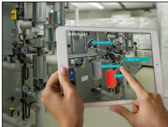
Figura 28: Inspeção Predial com uso de Realidade Aumentada
