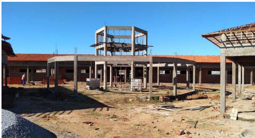
Figura 46: Cenário central da obra de aplicação do estudo
