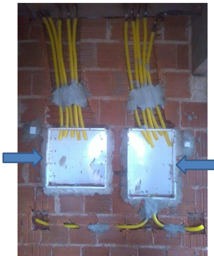
Figura 21. Assentamento dos quadro VDI e de distribuição.
