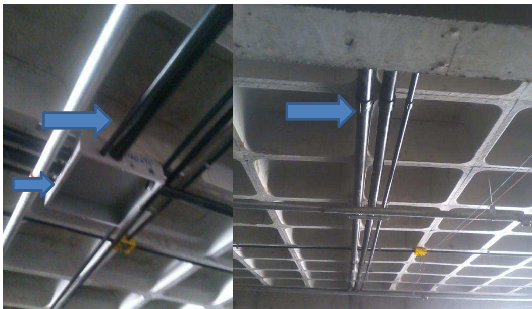
Figura 23. a) Fixação dos eletrodutos e caixas de passagens e b) Eletrodutos do ramal de saída do gerador.
