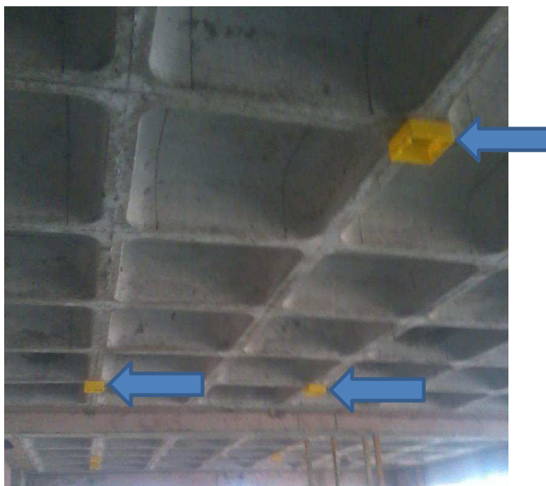
Figura 14. Colocação das caixas de passagens no teto.
