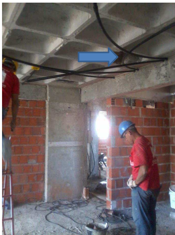
Figura 15. Colocação dos eletrodutos roscáveis.
