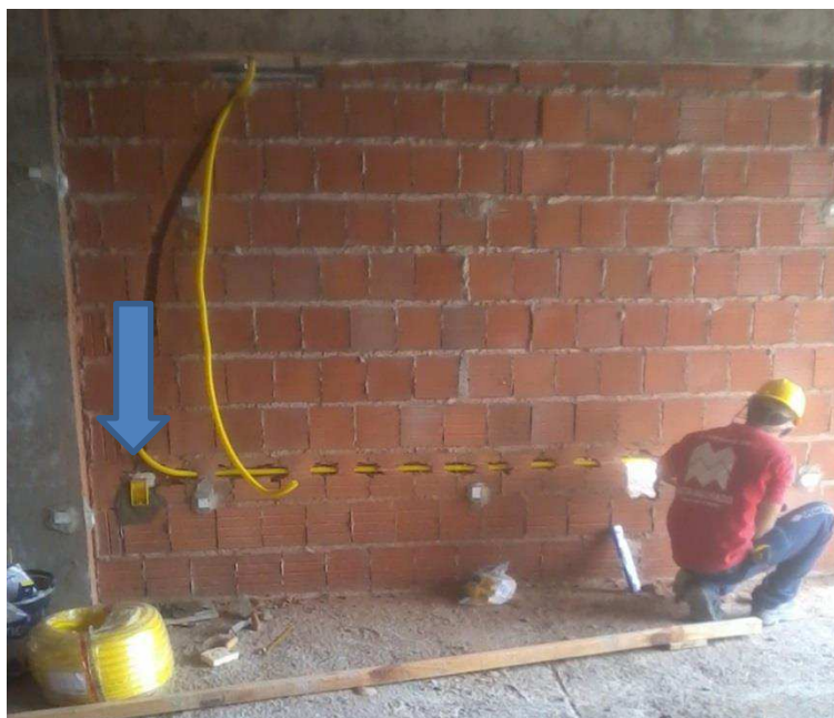
Figura 20. Assentamento das caixas de parede.
