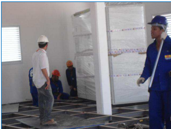
Figura 29– Montagem dos equipamentos da SE Envase.
