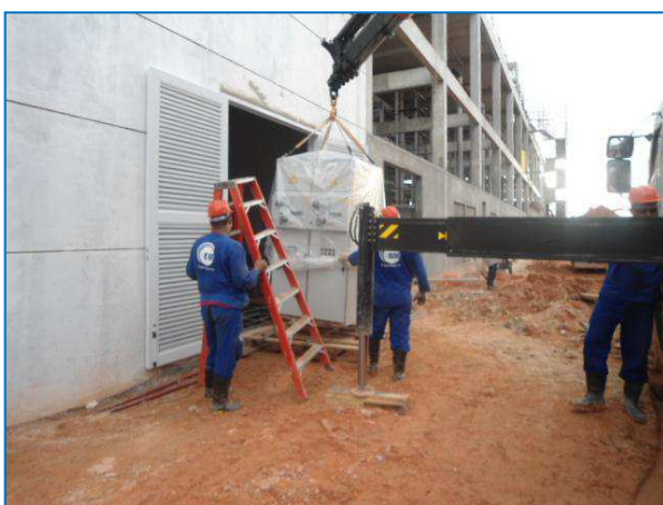
Figura 31– Montagem dos equipamentos da SE Envase.
