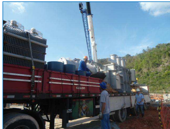
Figura 18 – Descarga do transformador.
