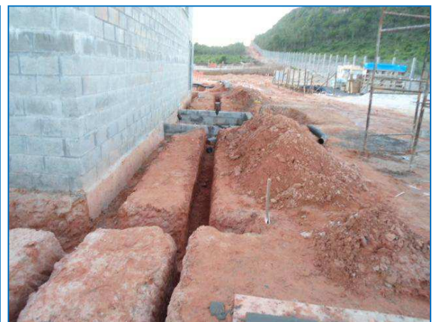
Figura 24 – Escavação da malha de terra.
