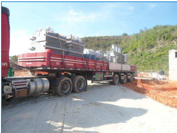
Figura 17 – Descarga do transformador.
