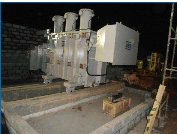
Figura 22 – Descarga do transformador.
