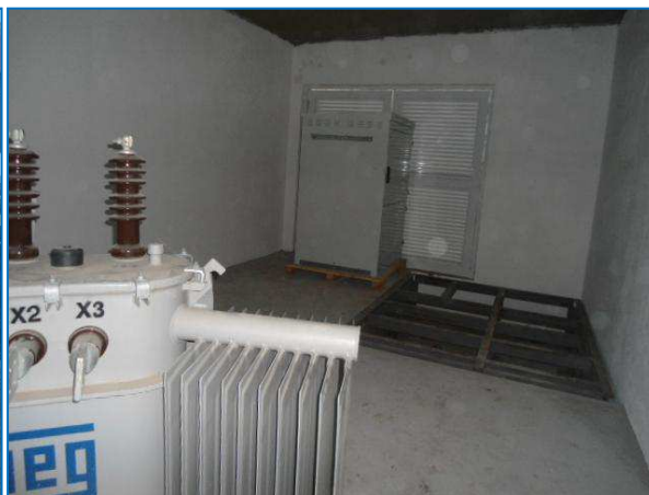
Figura 42 - montagem dos equipamentos da SE Poço.
