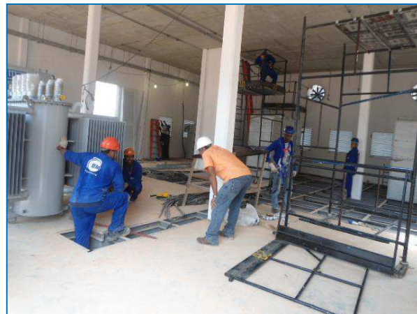
Figura 30– Montagem dos equipamentos da SE Envase.
