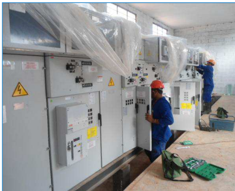
Figura 7 - Remoção e montagem PMT 1 – SE Entrada.
