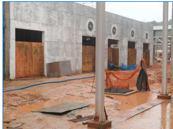
Figura 27 – Acessos da SE utilidades.
