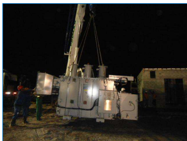
Figura 19 – Descarga do transformador.
