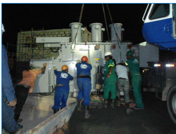
Figura 20 – Descarga do transformador.
