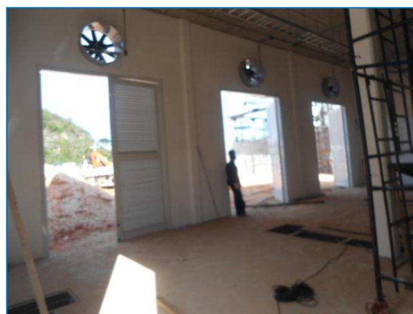
Figura 32– Montagem dos equipamentos da SE Envase.
