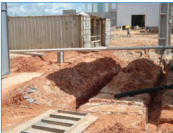
Figura 23 – Escavação da malha de terra.
