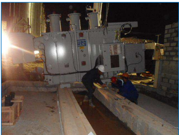
Figura 21 – Descarga do transformador.
