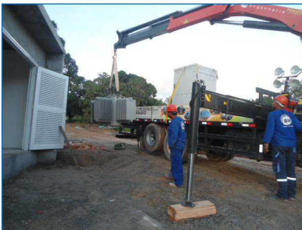
Figura 42 - montagem dos equipamentos da SE Poço.
