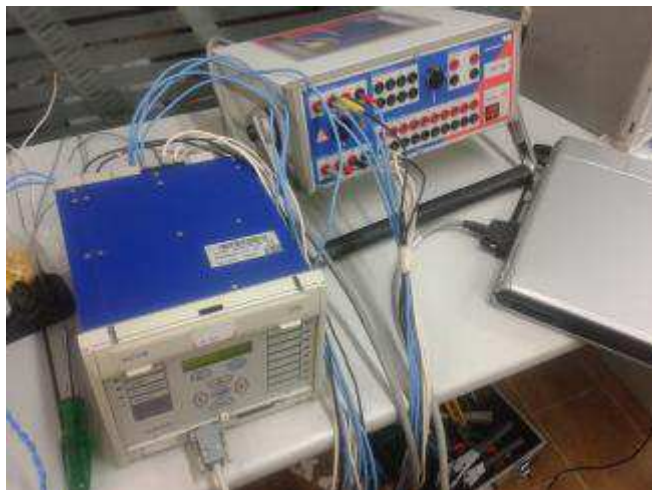
Figura 17. Realização de testes com a mala e o relé P441.
