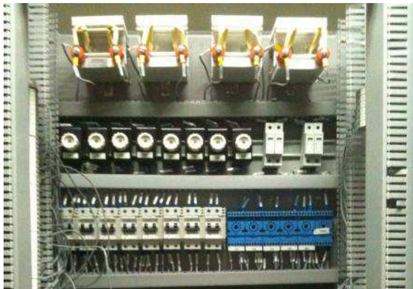
Figura 22. Vista do painel CP2R - SE MATATU sendo montado.
