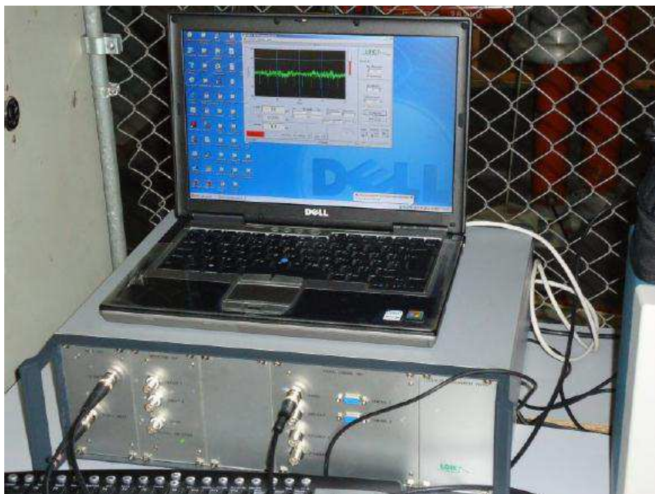
Figura 40- Software LDS-6 no notebook que está sobre o detector de DP
