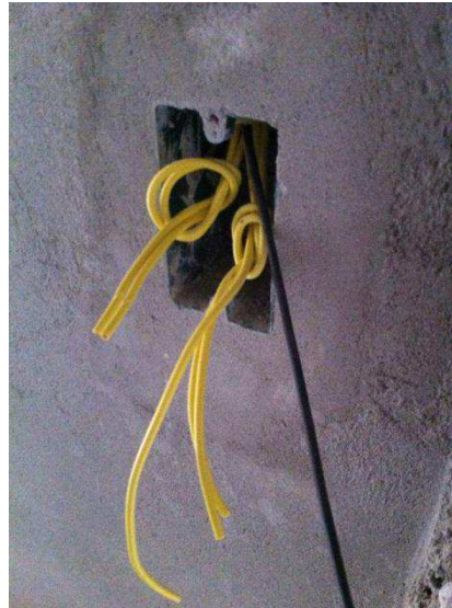
Figura 5. Presença de um condutor fase no interruptor de entrada da suíte 01.
