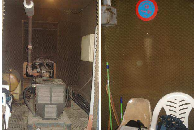
Figura 8 - Recinto utilizado como deposito de objetos.
