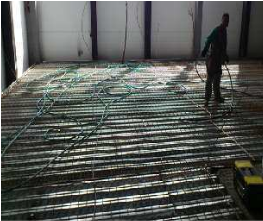
Figura 8: (a). Malha de aterramento da subestação. (b). Aterramento destinado ao transformador. (c). Execução das conexões do aterramento. (d). Solda exotérmica executada.
