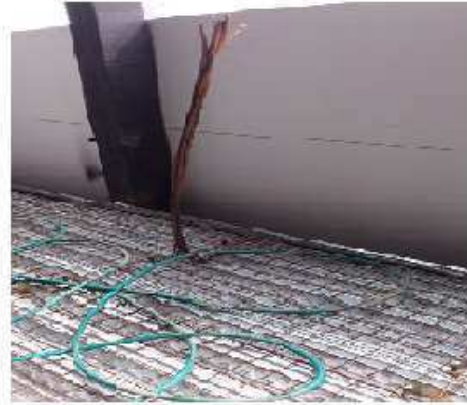
Figura 8: (a). Malha de aterramento da subestação. (b). Aterramento destinado ao transformador. (c). Execução das conexões do aterramento. (d). Solda exotérmica executada.
