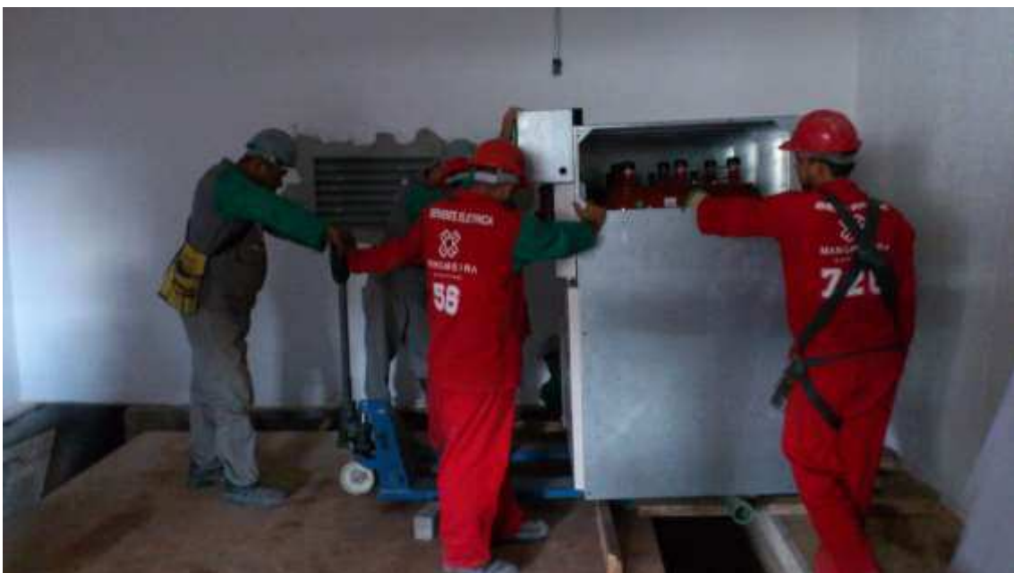
Figura 10: Montagem das subestações.
