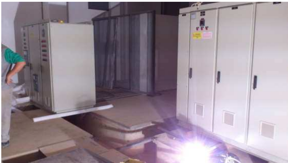
Figura 11: Adequação da estrutura civil da subestação.
