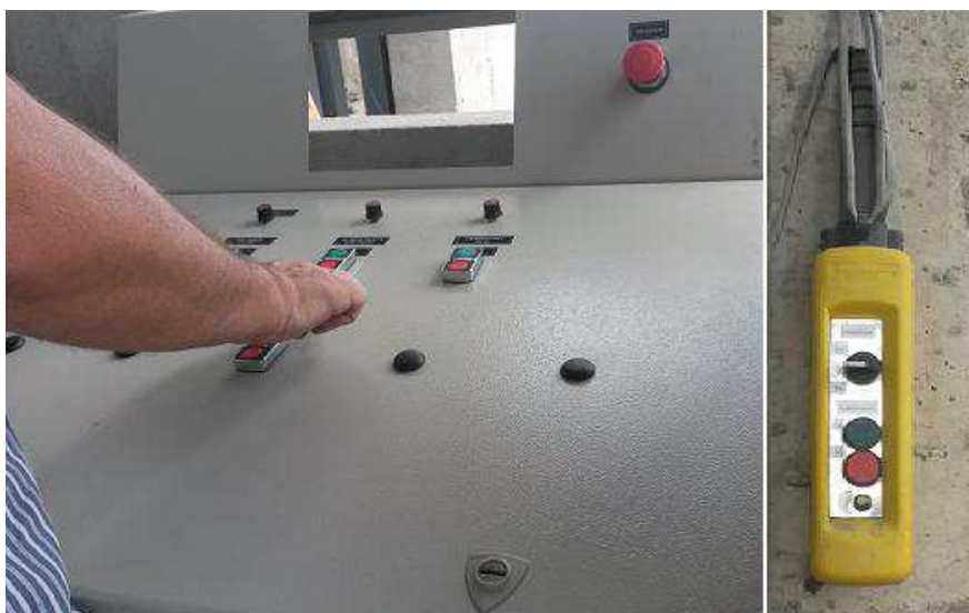
Figura 24: Fotografia da mesa comando remoto CCMI-01 e botoeira.
