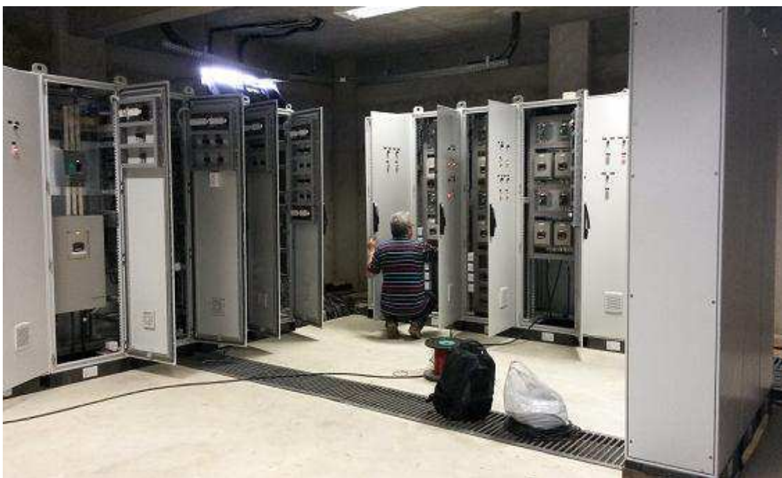
Figura 22: Foto referente a visita técnica de instalação e teste dos CCM.
