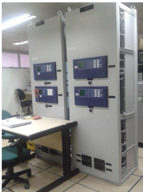
Figura 3.22 – Painéis montados para o processo de retrofit .
