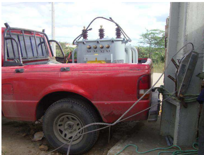
Figura 57 – Transformador sendo posicionado próximo ao poste.
