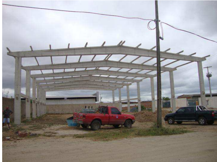
Figura 53 – Vista do galpão em construção.
