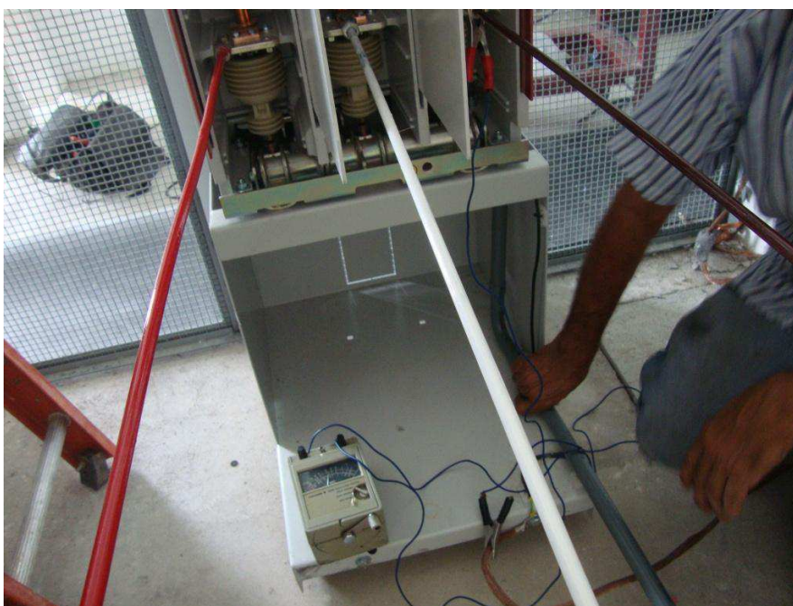
Figura 80 – Medição de isolamento entre terminal fase do disjuntor e o terra.
