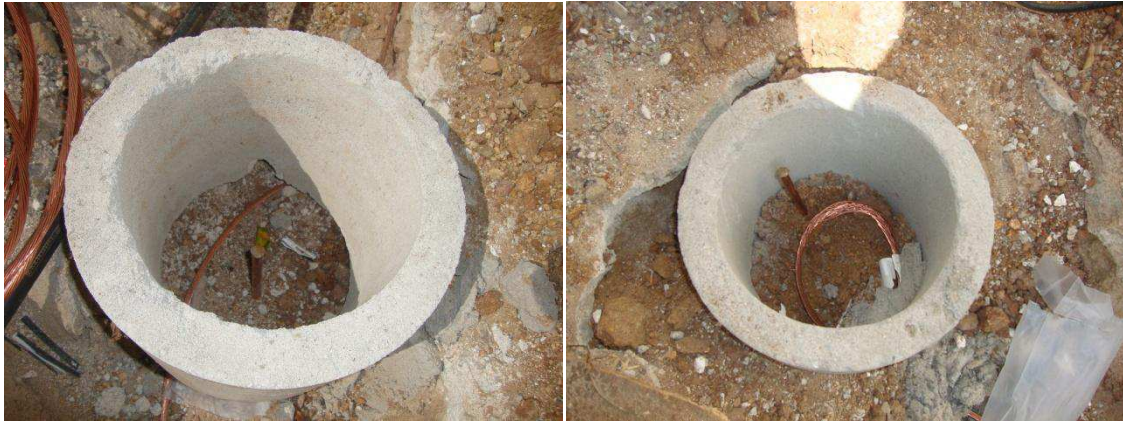
Figura 42 – Condutor de interligação acessando as hastes dentro de seus invólucros.
