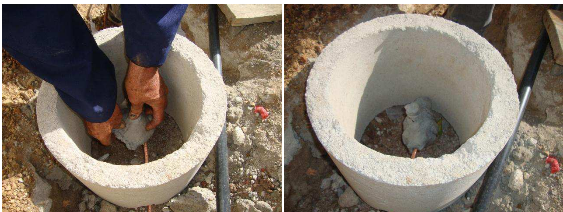
Figura 44 – Aplicação de massa isolante sobre a conexão cabo e haste.
