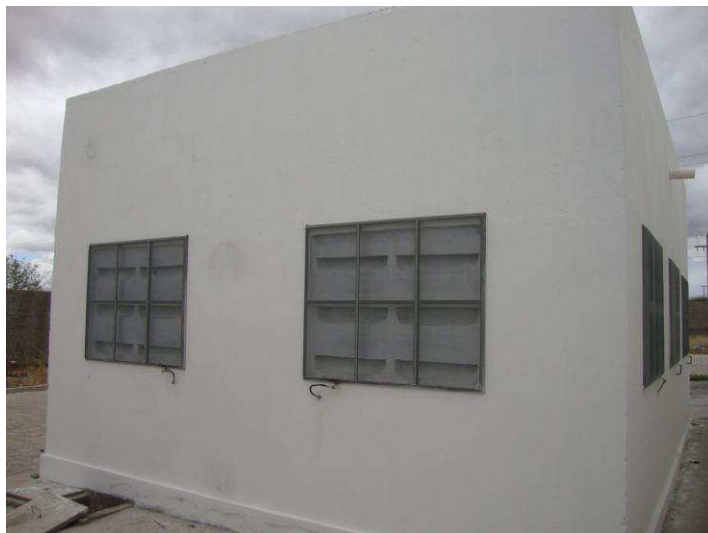
Figura 66 – Vista das entradas de ventilação da estrutura.
