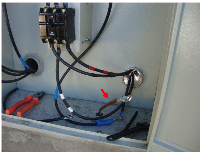
Figura 48 – Detalhe do cabo de aterramento com conector próprio.
