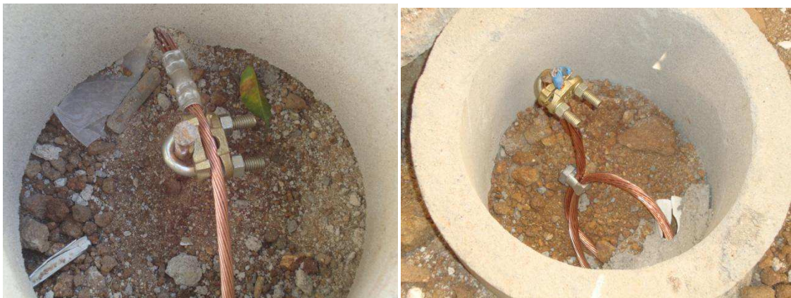
Figura 43 – Conectores fixando o cabo de interligação da malha às hastes de aterramento.
