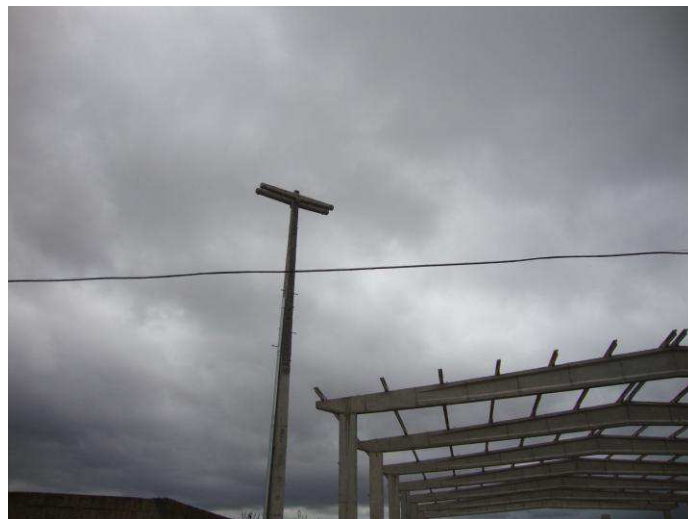
Figura 54 – Galpão e seu poste de alimentação.
