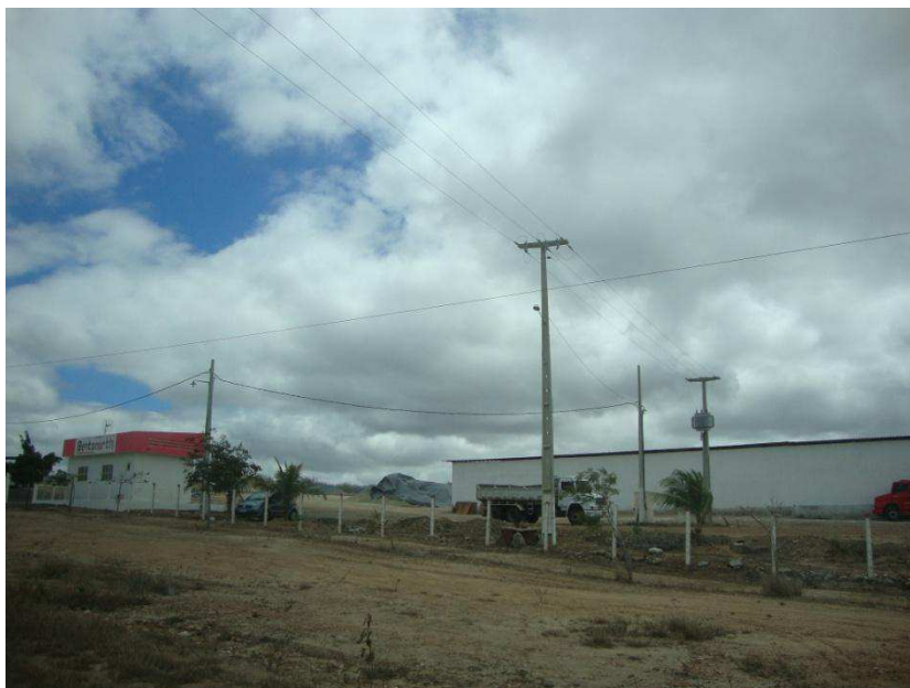
Figura 31 – Fachada da empresa com os dois postes ao fundo.
