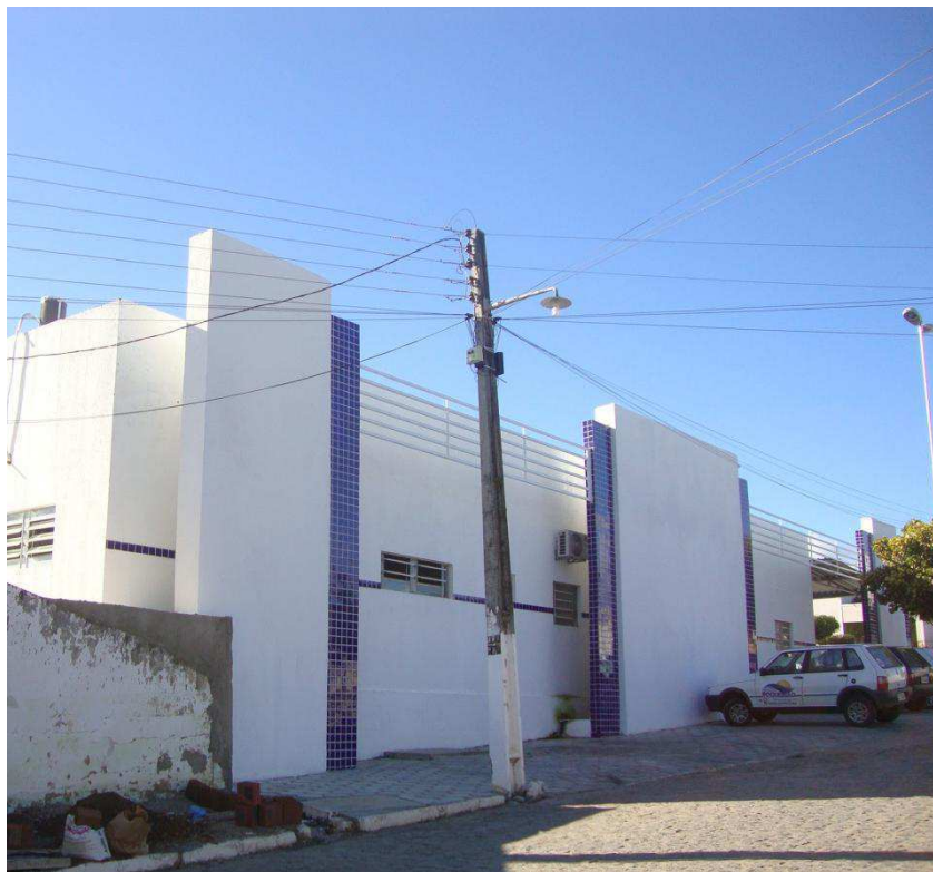
Figura 38 – Vista do Hospital de Boqueirão, com o poste e quadro de medição à esquerda.
