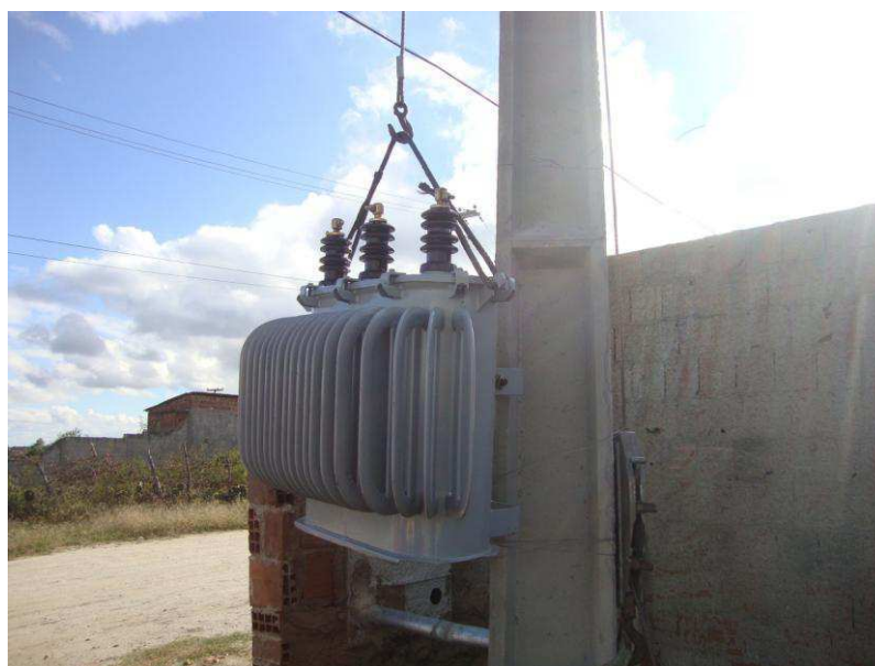
Figura 58 Transformador sendo içado pelo gancho.
