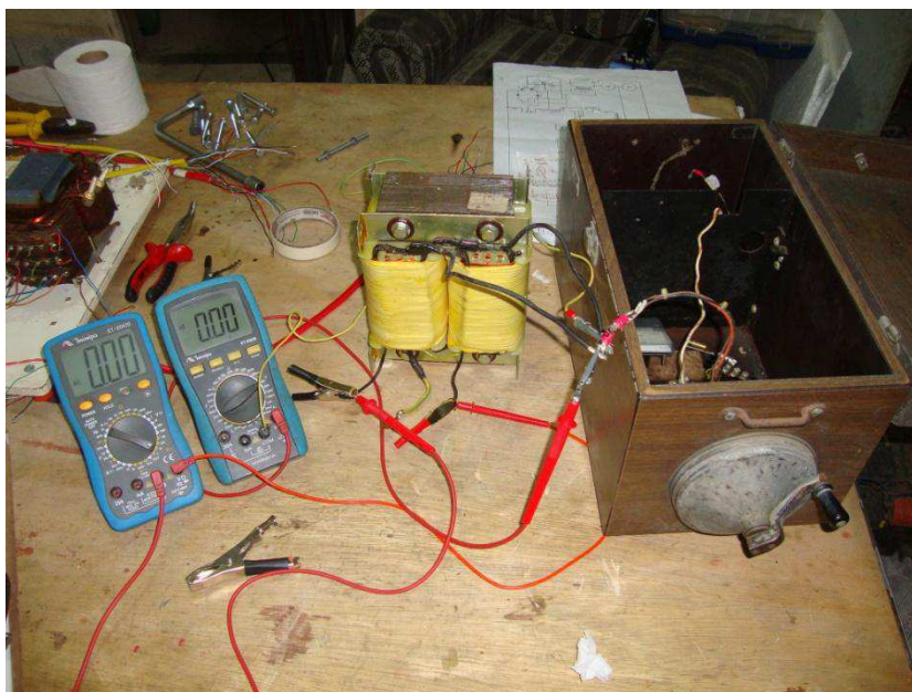
Figura 12 – Gerador do TTR sendo utilizado para alimentar um transformador de relação 4.1:1 pelos terminais de baixa tensão (terminais superiores).
