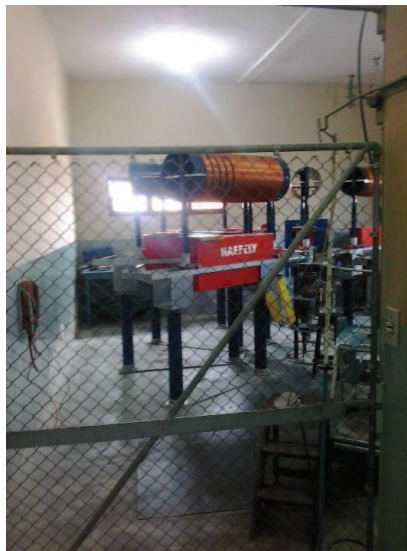
Figura 4.10 – Porta gradeada fechada.
