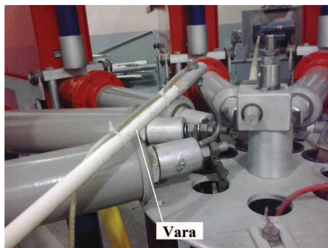
Figura 4.5 – Vara tocando o terminal de um capacitor.
