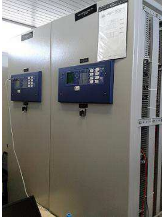
Figura 8 Painél de proteção de 500 kV
