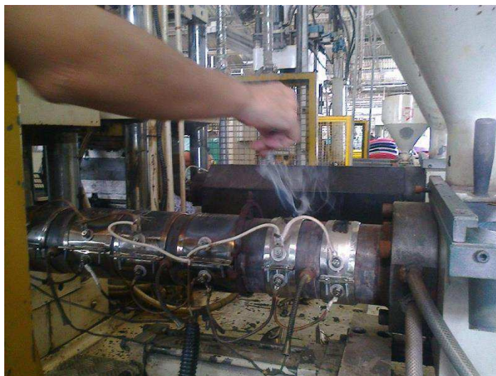
Figura 12. Teste de funcionamento da resistência após substituição.
