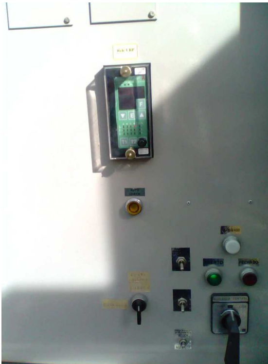
Figura 13 – Anteporta do religador antes do retrofit, com relé PEXTRON.
