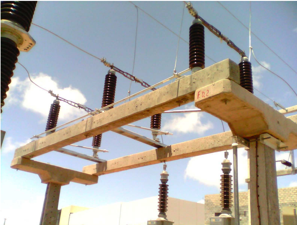
Chave motorizada montada na horizontal.
