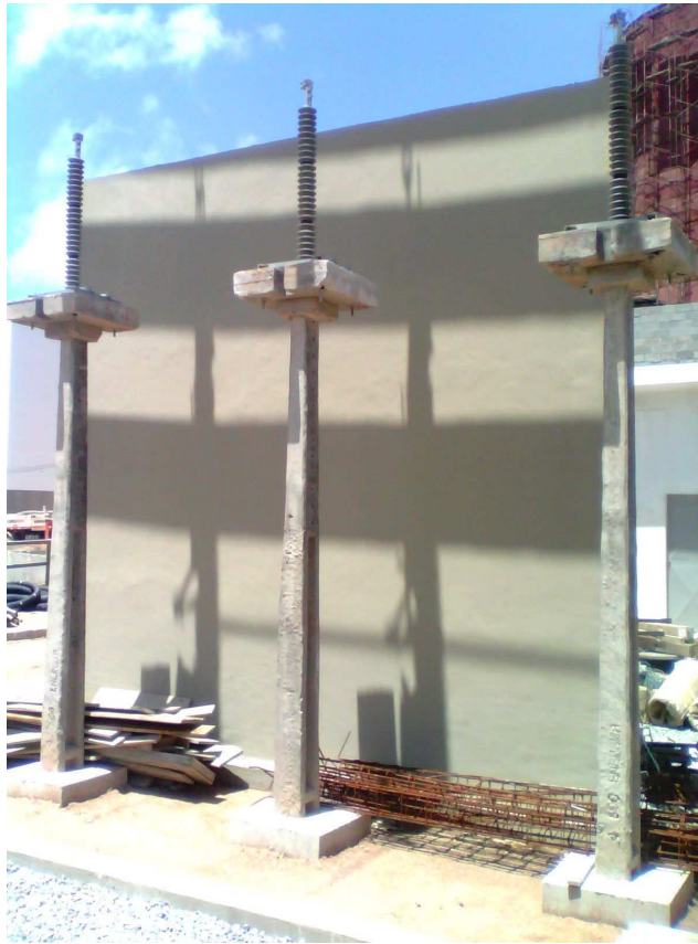
Parede corta-fogo e pára-raios.
