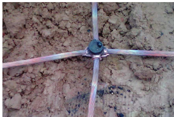
Figura 7 – Solda exotérmica.
