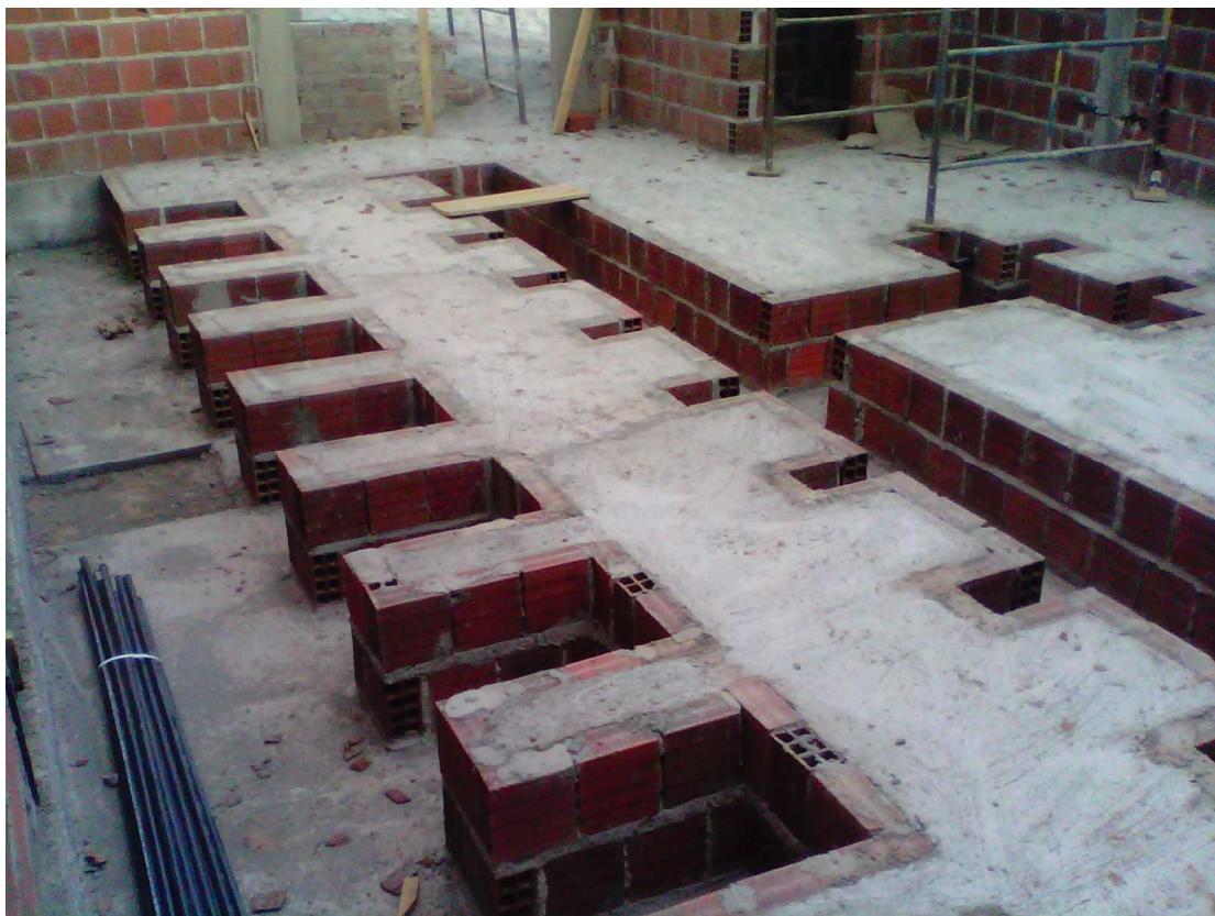
Interior da casa de comando em construção.
