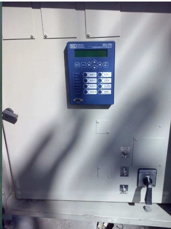
Figura 14 – Anteporta do religador depois do retrofit, com relé SEL-751.
