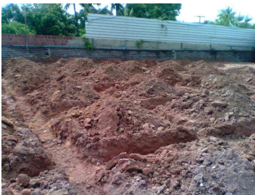
Figura 6 – Valetas para a malha de aterramento.
