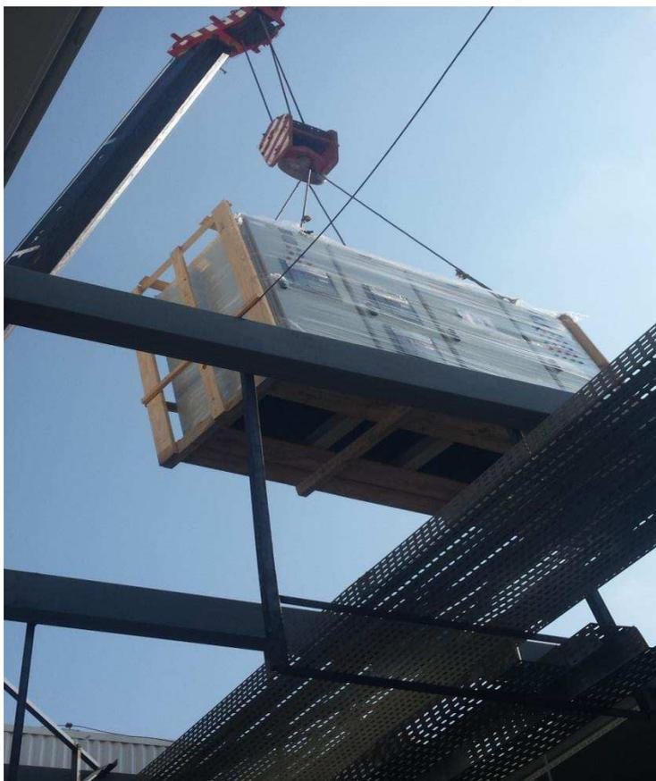
Figura 3.13. Painel sendo transportado para a subestação.
