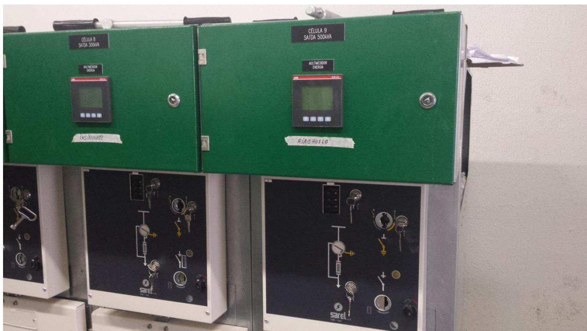
Figura 3.15. Células para as lojas na subestação.
