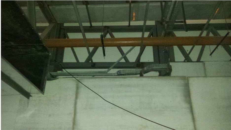
Figura 3.9. Eletrocalha impedindo conclusão da parede.
