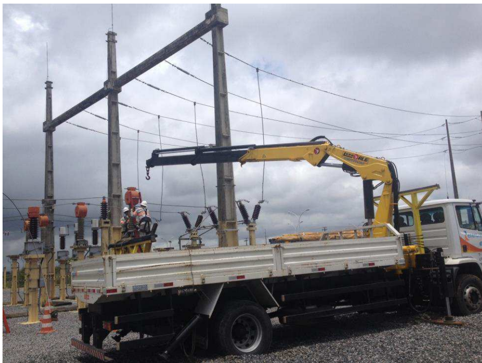
Figura 4.7. Energisa realizando a manutenção na subestação.
