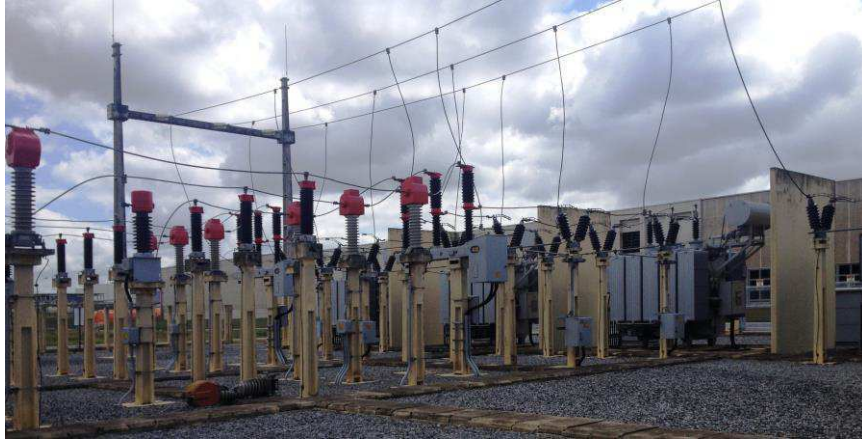
Figura 3.2 Subestação 69/13.8 kV.
