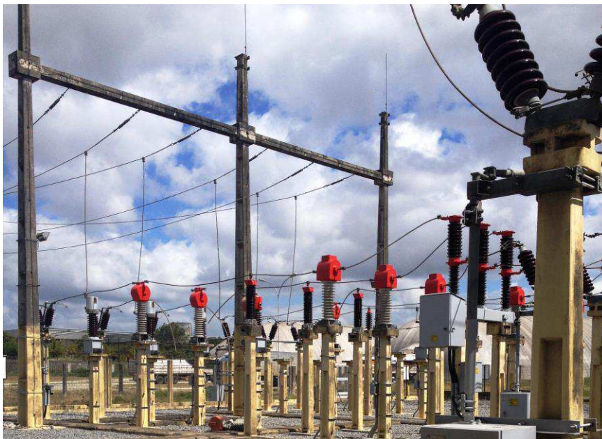
Figura 3.3. Subestação 69/13.8 kV.
