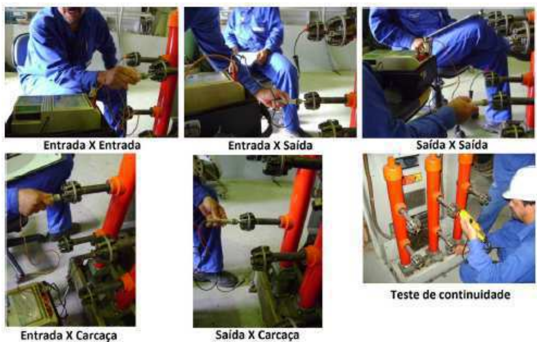
Figura 28 - Medição de isolamento do disjuntor.
