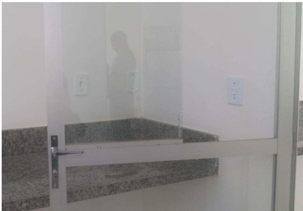
Figura 1. Fotografia de interruptor indevidamente instalado
