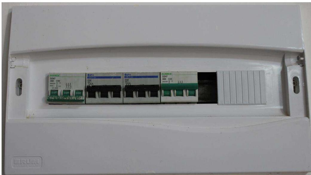
Figura 2. Fotografia do quadro de distribuição dos condicionadores de ar
