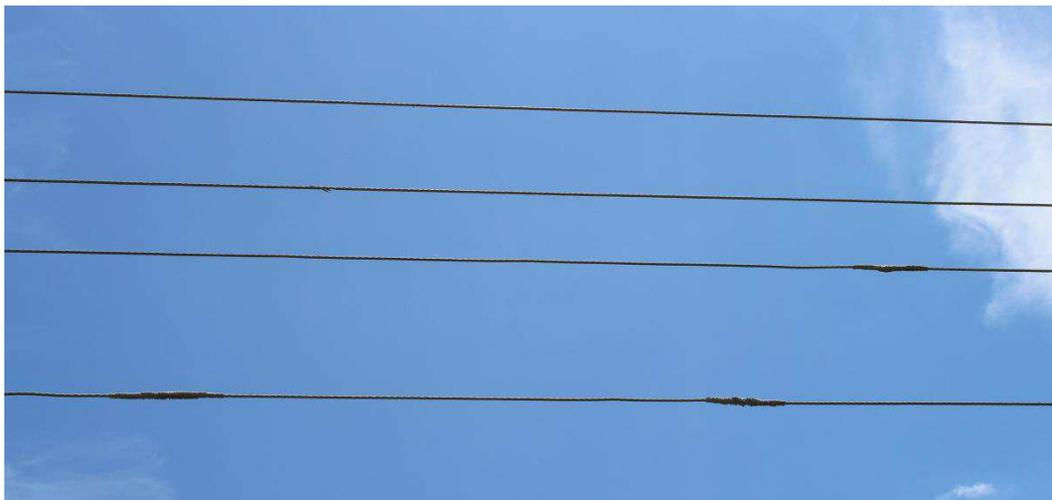
Figura 8. Fotografia da rede de distribuição com emendas
