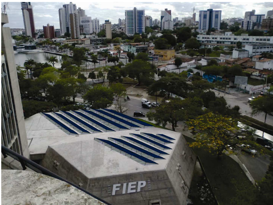
Figura 9.1. Montagem do prédio da FIEP mostrando os painéis dispostos na laje apontados para o norte.
