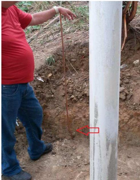
Figura 6. Haste de aterramento envergada após tentativa de fixação.
