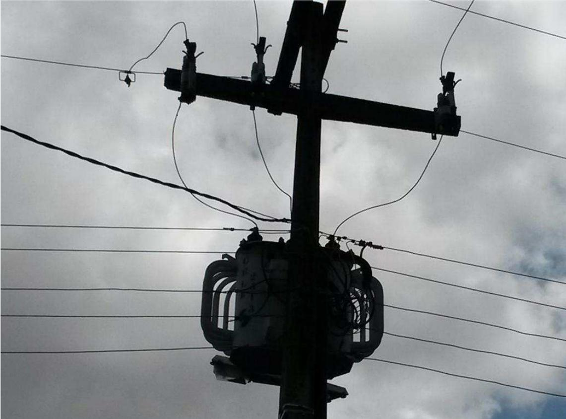
Figura 13. Transformador de 75 kVA que alimenta a rede secundária de distribuição.
