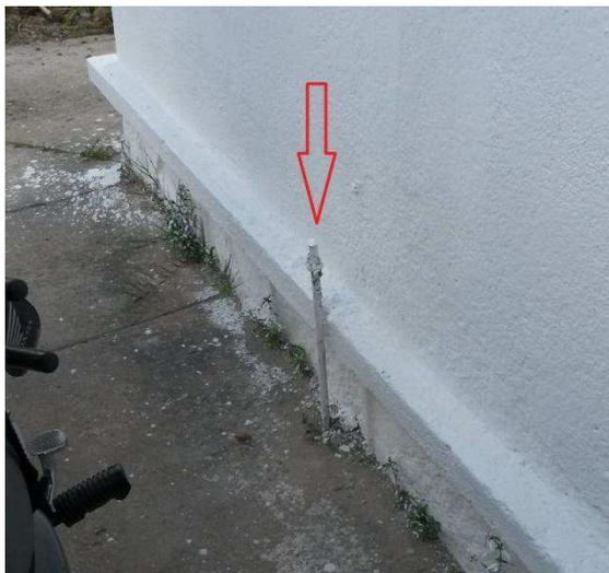
Figura 2. Aterramento da antiga instalação.
