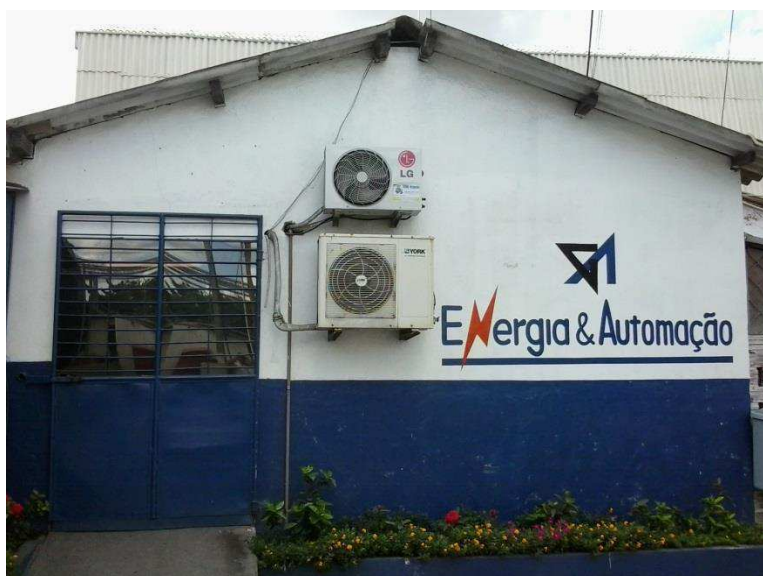
Figura 5 – Fotografia do Setor de Energia & Automação da Unidade – 01
