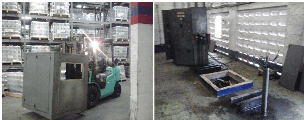
Figura 19 - Remoção dos equipamentos da antiga SE-04.
