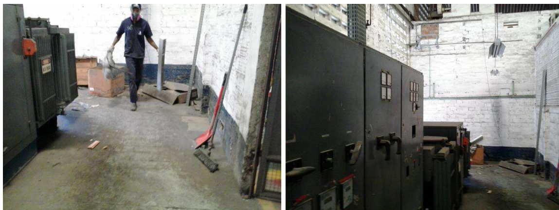
Figura 18 – Fotografia da limpeza da SE-04
