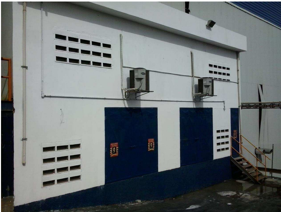
Figura 16 – Fotografia da parte externa da subestação SE-01 após a pintura.
