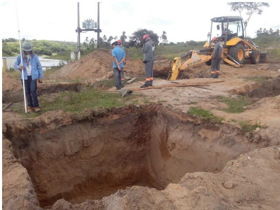
Figura 18 - Escavação para torre com fundação em sapata.
