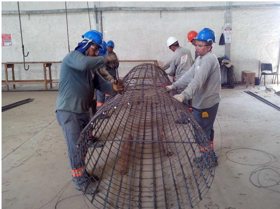
Figura 20 - Confeção de armação para fundação tipo tubulão.
