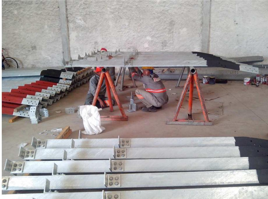
Figura 25 - Atividade de fixação de orelhas e pintura de *stubs*.
