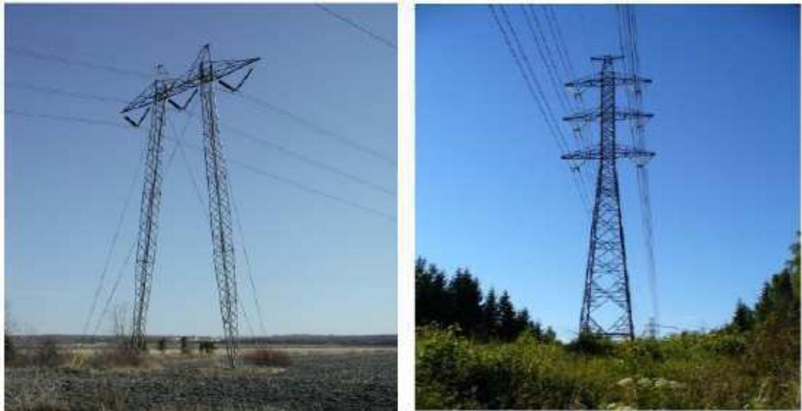
Figura 3 - Classificação das torres quanto à forma de resistir aos carregamentos (estaiada - à esquerda, autoportante - à direita).
