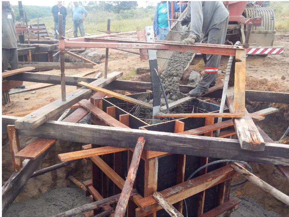
Figura 24 - Concretagem de uma fundação tipo sapata.
