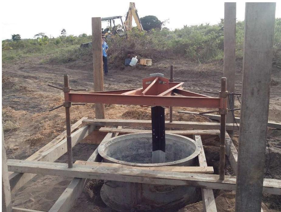
Figura 22 - Fundação com stub nivelado.
