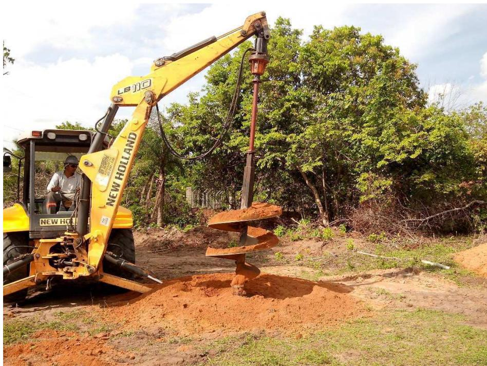
Figura 17- Escavação com trado acoplado à retroescavadeira.
