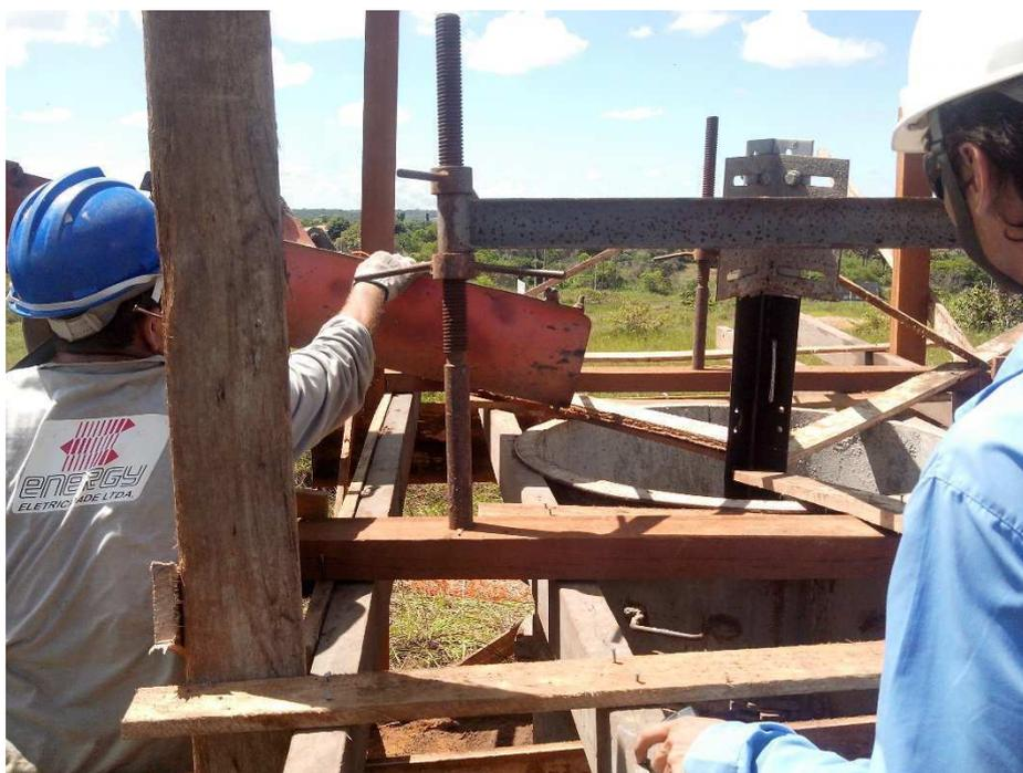
Figura 23 - Concretagem de uma fundação tipo tubulão.
