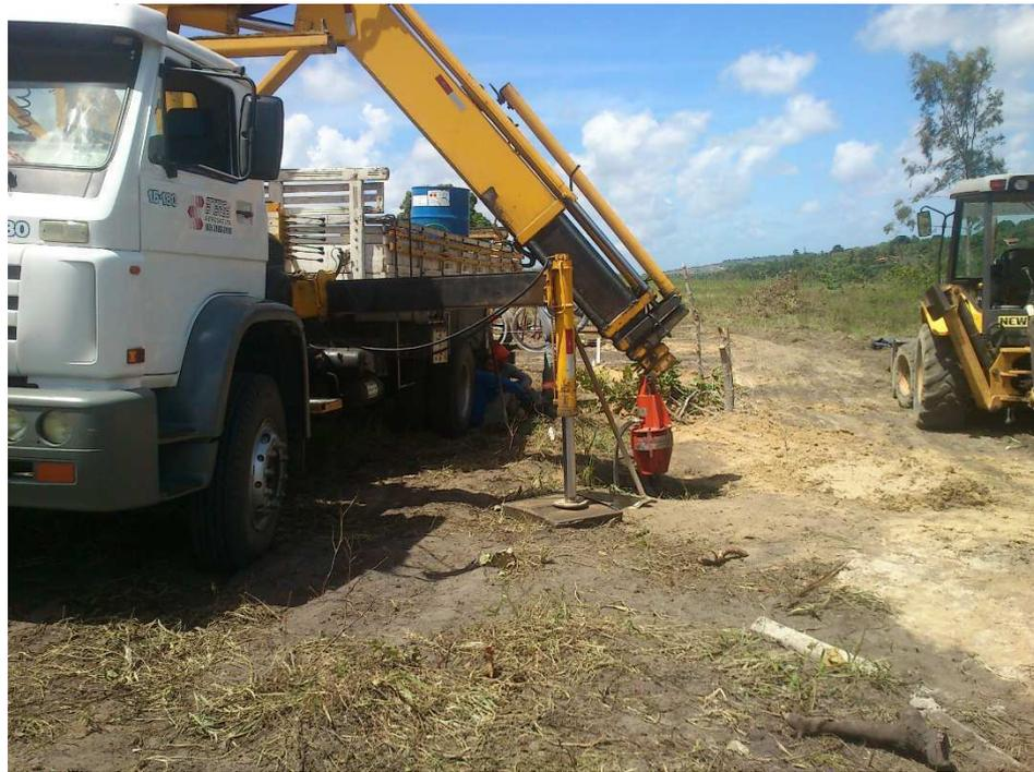
Figura 16 - Escavação com trado acoplado à caminhão Munck.
