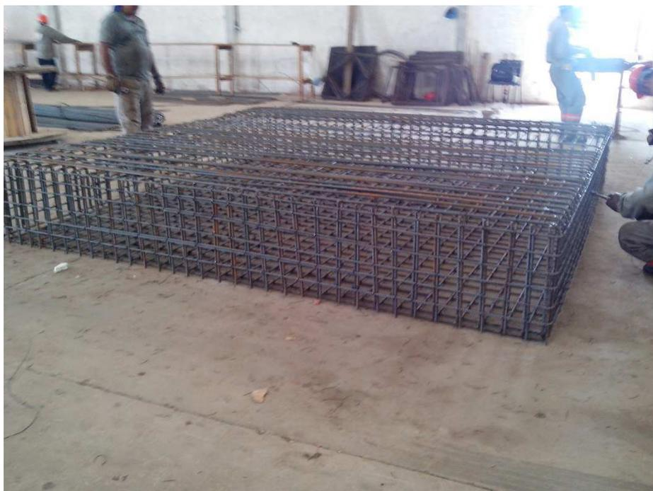
Figura 21 - Confeção de armação para fundação tipo sapata.
