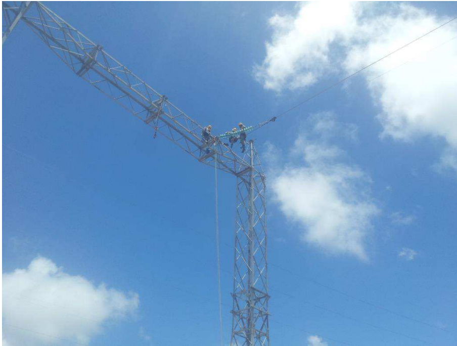
Figura 14. Montadores fixando isoladores.
