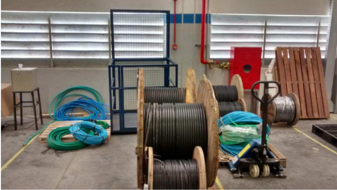
Figura 14. Bobinas de cabos a serem instalados.
