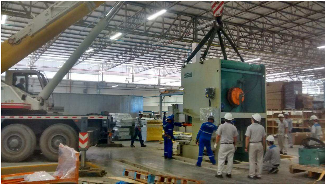
Figura 13. Empresa realizando instalação de uma prensa da linha de produção.
