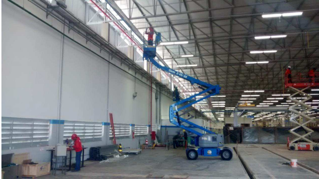
Figura 12. Fase inicial da execução do projeto. Instalação da infraestrutura para os condutores.
