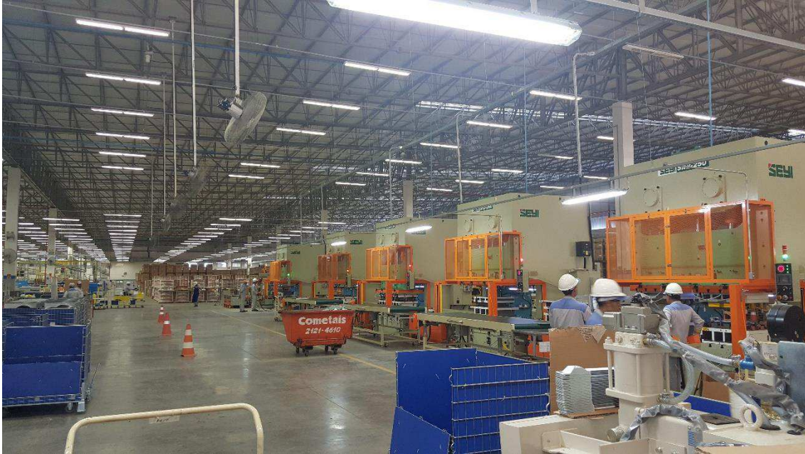
Figura 19. Linha de produção já energizada e em fase de testes.
