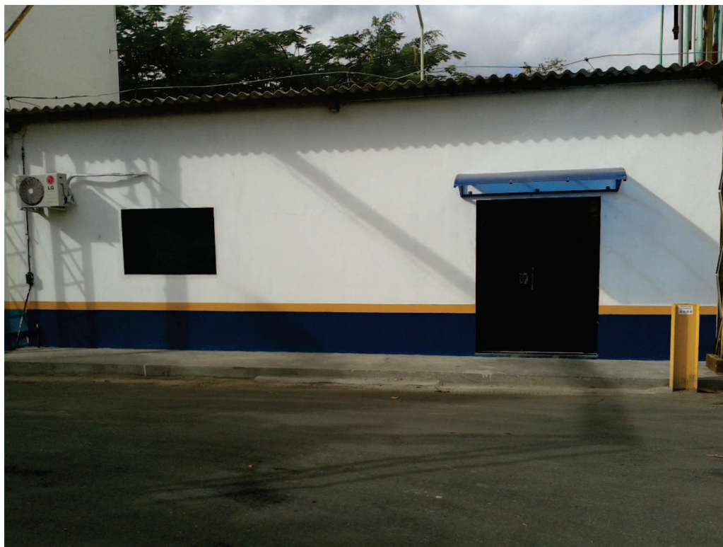
Figura 2.7 – Fotografia do Setor de Energia e Automação da Unidade - 01
