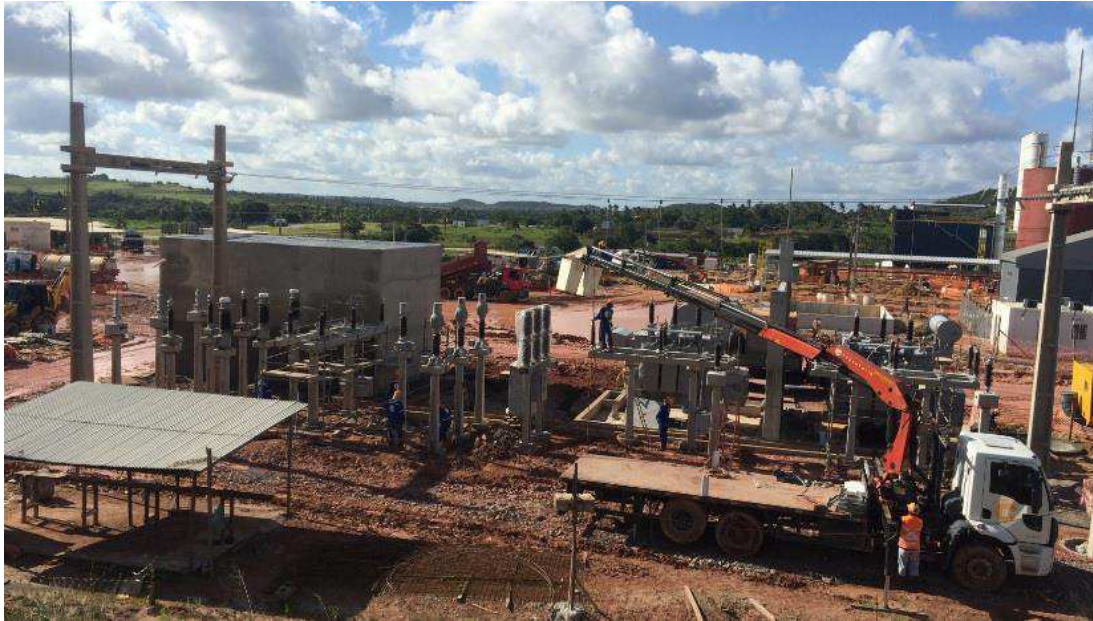
Figura 20 – Colocação dos equipamentos no local com o caminhão munk.
