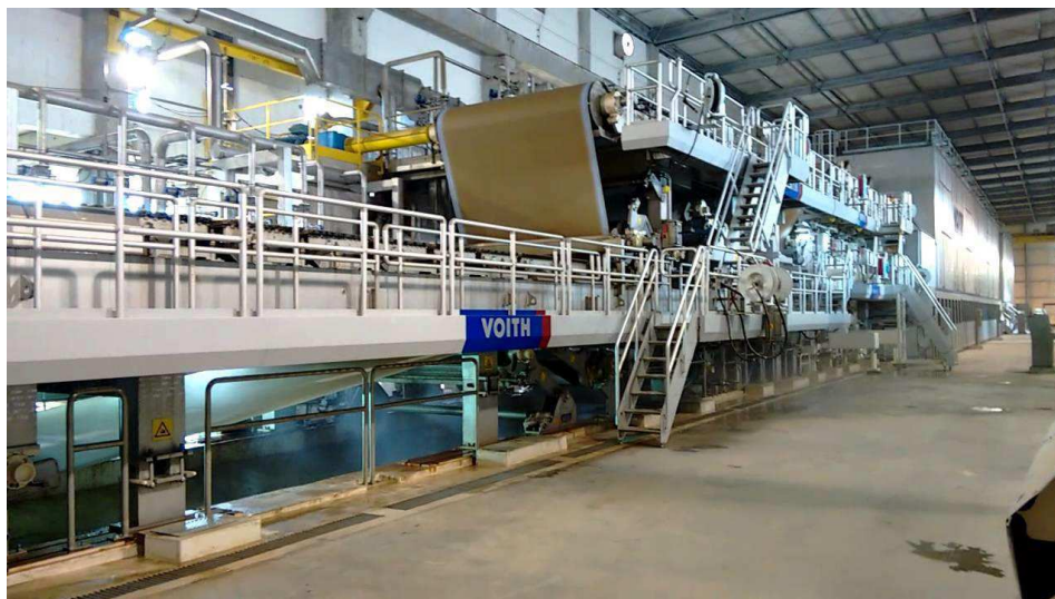
Figura 4 – MP 24 no piso +14500.
