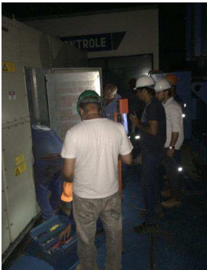
Figura 46 – Desligamento para conexão do circuito a um painel de média que não podia ser desligado.
