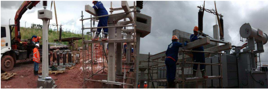
Figura 18 – Instalação da chave seccionadora do trafo 1.
