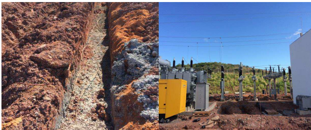
Figura 22 – Malha de aterramento.
