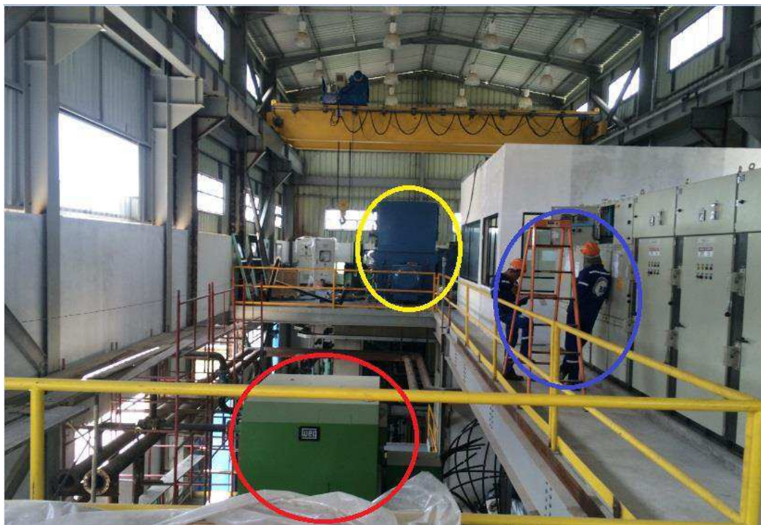
Figura 38 – Geradores 3 e 4 e atividades nos cubículos de média da casa de força nova.
