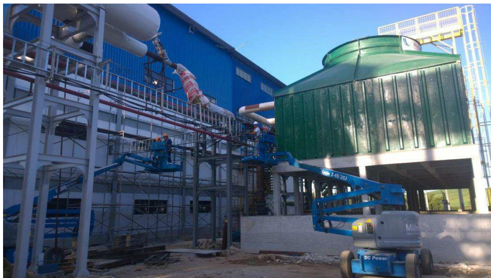
Figura 36 – Lançamento de cabos no pipe rack.
