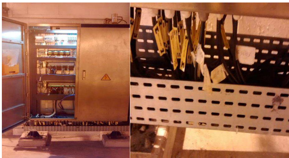
Figura 8 – Quadro com falhas na identificação.
