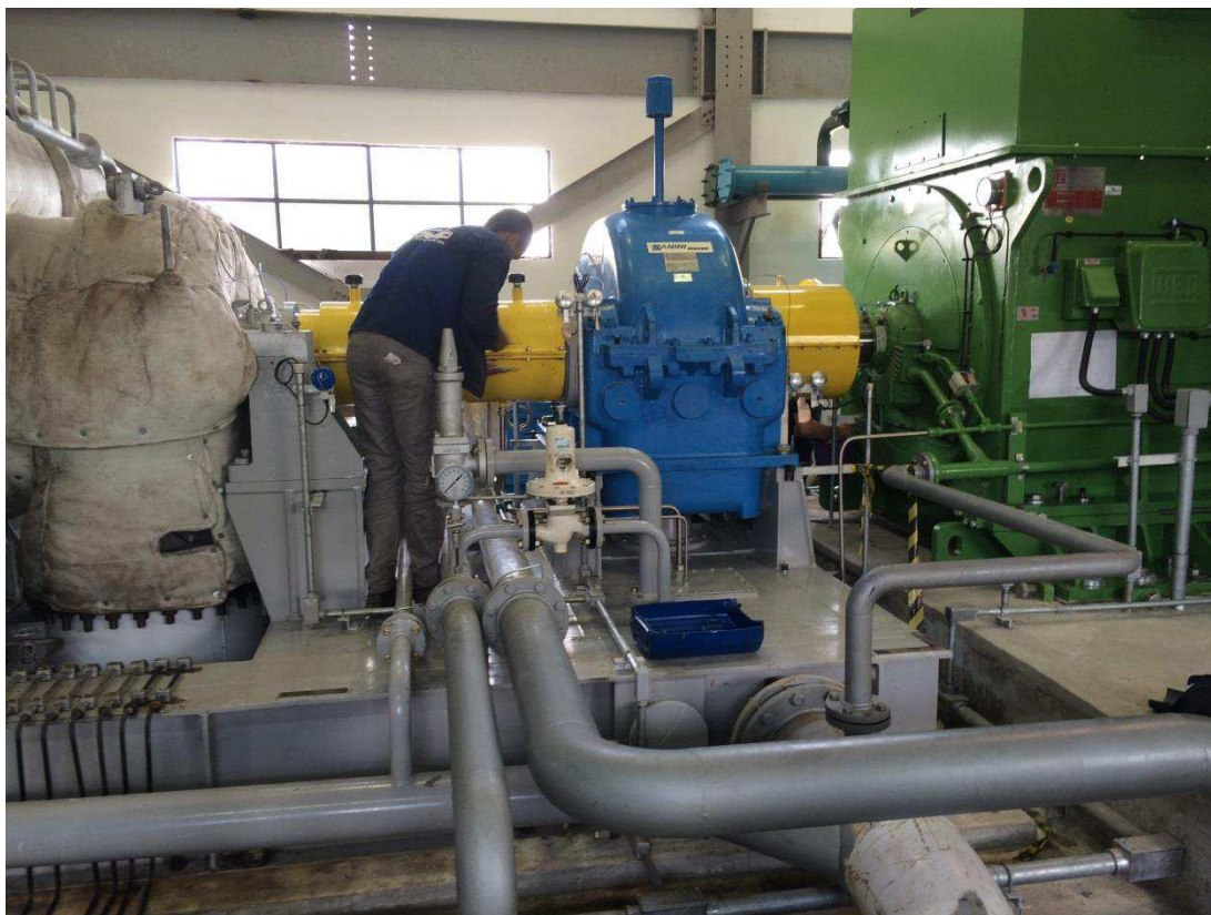
Figura 39 – Instalação do gerador 4.
