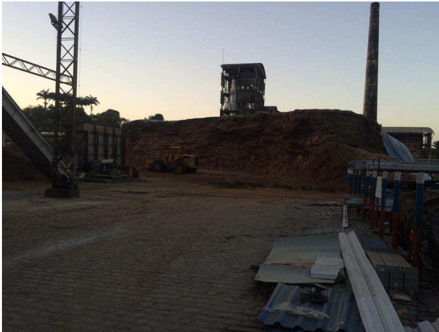
Figura 30 – Bagaço da cana utilizado nas caldeiras.
