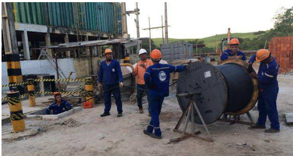
Figura 35 – Lançamentos de cabos na USJP.
