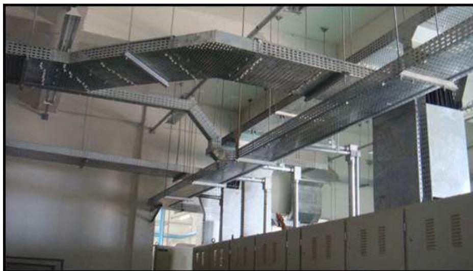
Figura 6: Instalação de Encaminhamento na Metalúrgica Musashi-PE.
