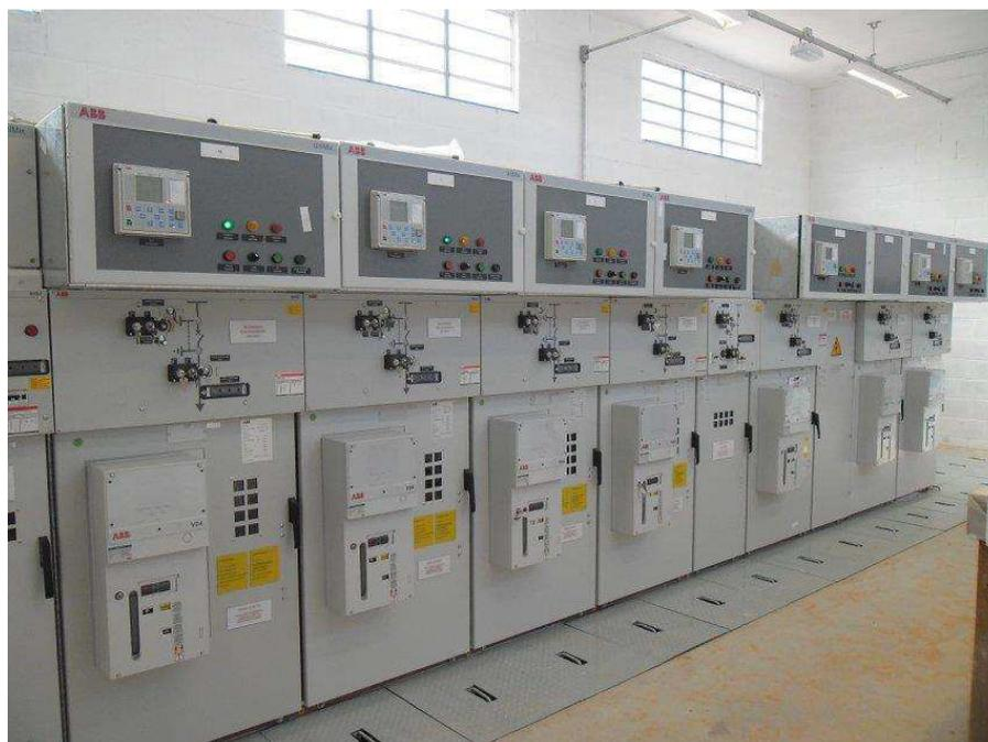
Figura 4: Painéis Média Tensão da SE 69kV Cervejaria Petrópolis-BA
