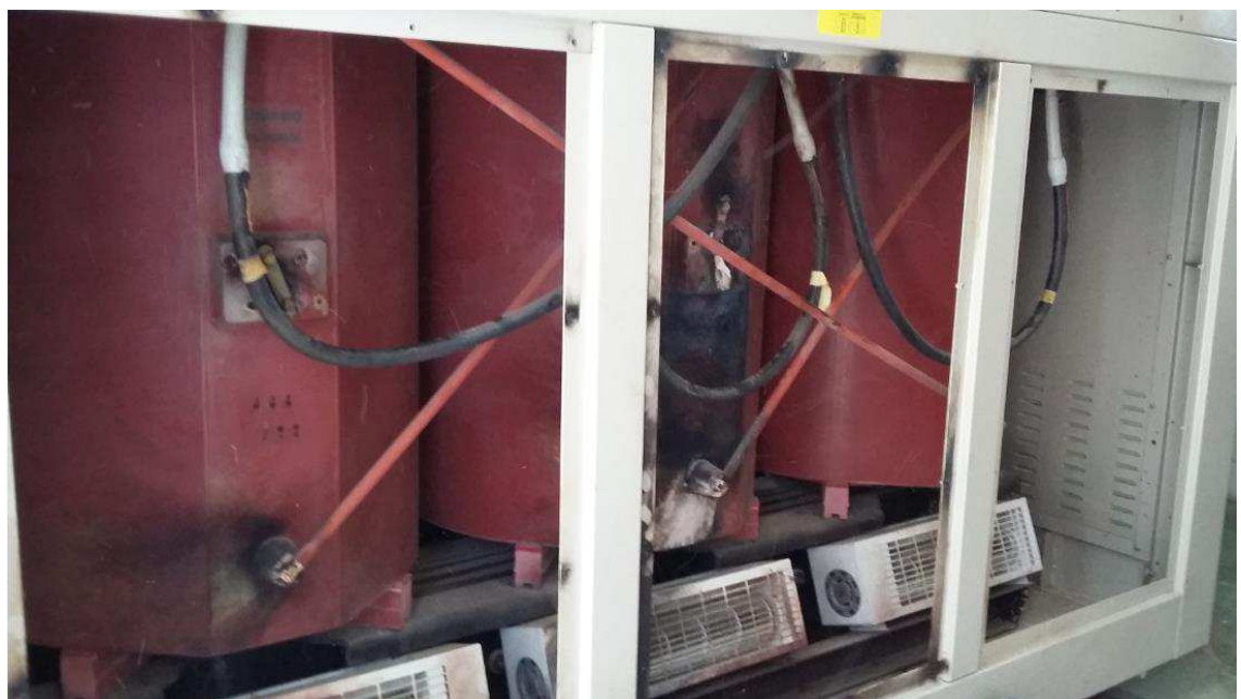
FIGURA 55: TRANSFORMADOR DANIFICADO
