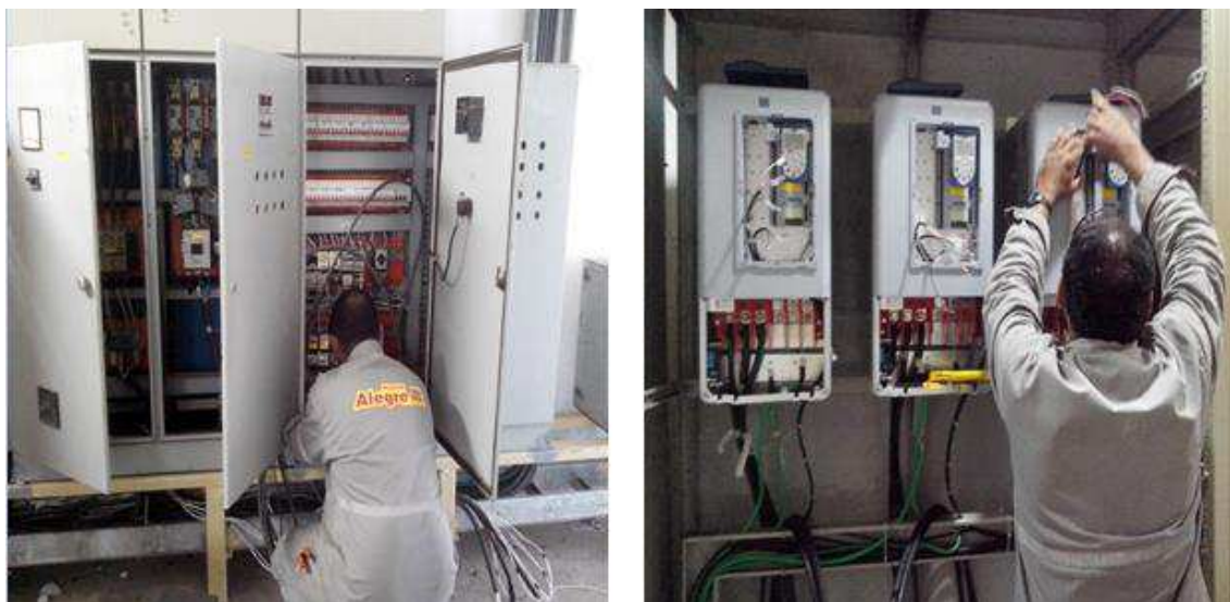
Figura 18 - Manutenção nos CCMs e painéis elétricos.
