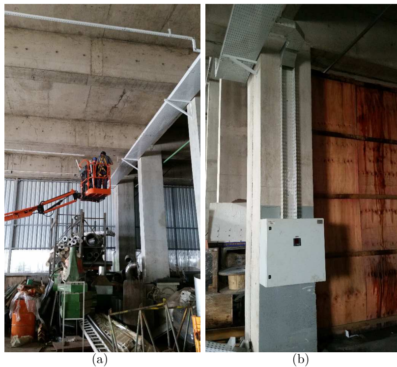
Figura 19 – Montagem de eletrocalhas, perfilados e quadros elétricos nos pisos 1 e 2 - Projeto elétrico do novo galpão da UGB-01.
