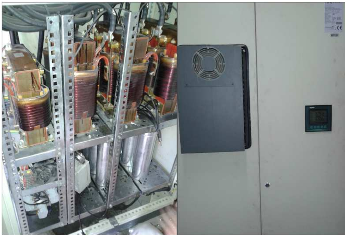
Figura 15 – Manutenção em banco de capacitores na SE02.
