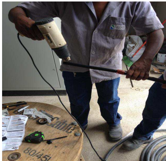
Figura 40: Aquecendo o cabo para retirar a umidade.
