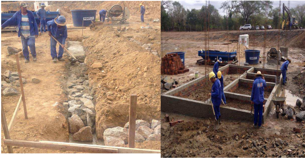
Figura 32: Fundação da SE (radier).
