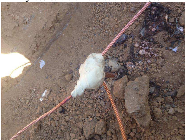
Figura 50: Conexão com a massa calafetar do tipo 3M.
