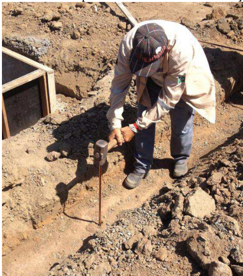
Figura 47: Cravando a haste para a malha de terra da balança de pesagem.
