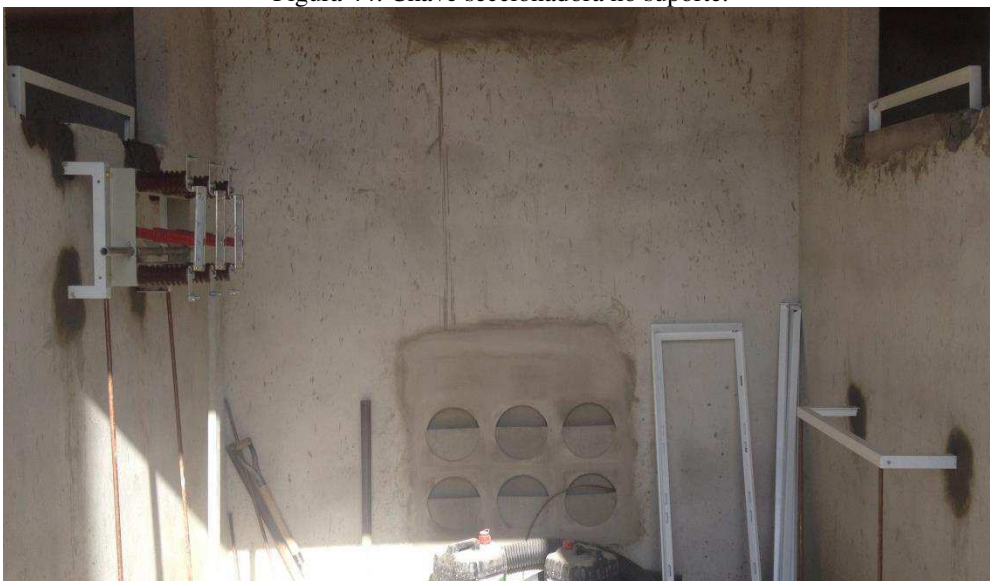
Figura 44: Chave seccionadora no suporte.
