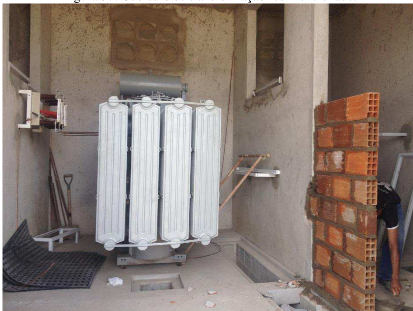
Figura 37: Cubículo de transformação redimensionado.
