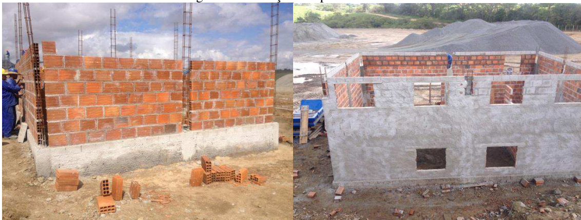
Figura 33: Elevação das paredes da SE.
