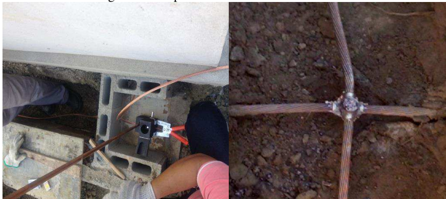
Figura 35: Preparando a solda e solda concluída.
