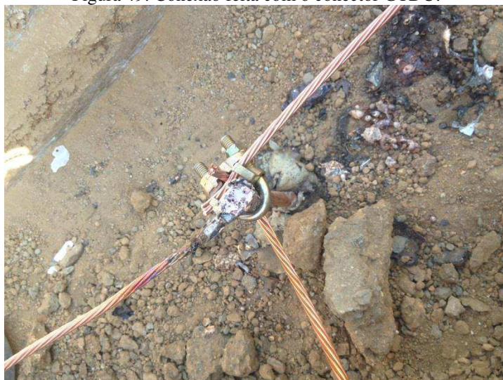
Figura 49: Conexão feita com o conector GTDU.
