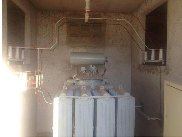
Figura 39: Barramento com a nova configuração.
