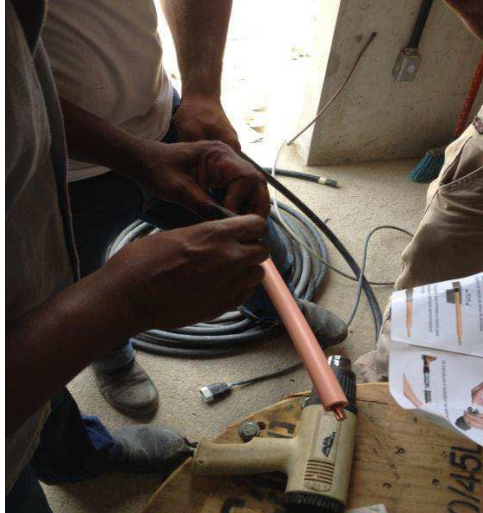
Figura 41: Colocando a manta de alívio de tensão.
