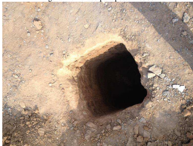
Figura 42: Buraco para poste 12/300.
